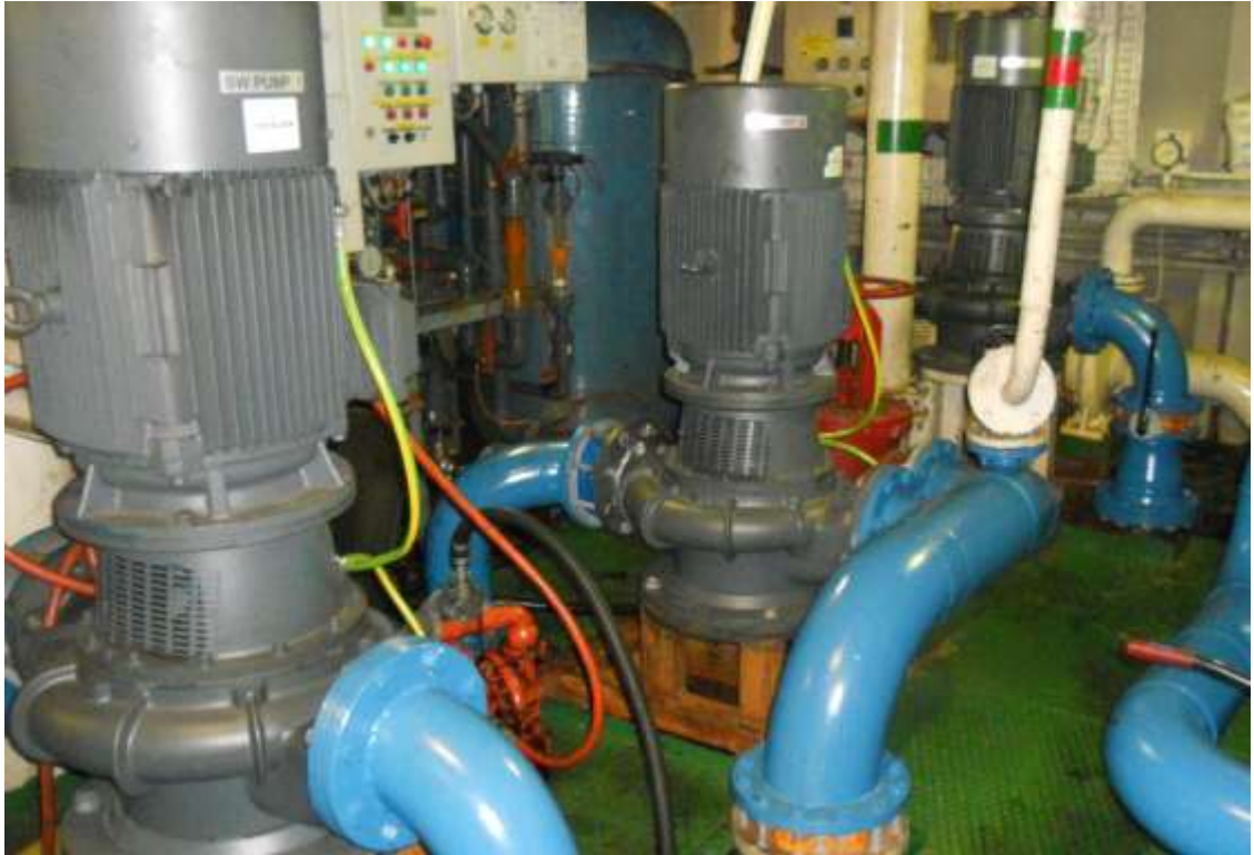
Kuva 13. Apukoneiden merivesipumput.
