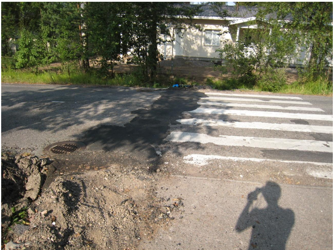
Kuva 8. Ajorata on oikeaoppisesti päällystetty kylmämassalla sen odottaessa lopullista asfalttia.
