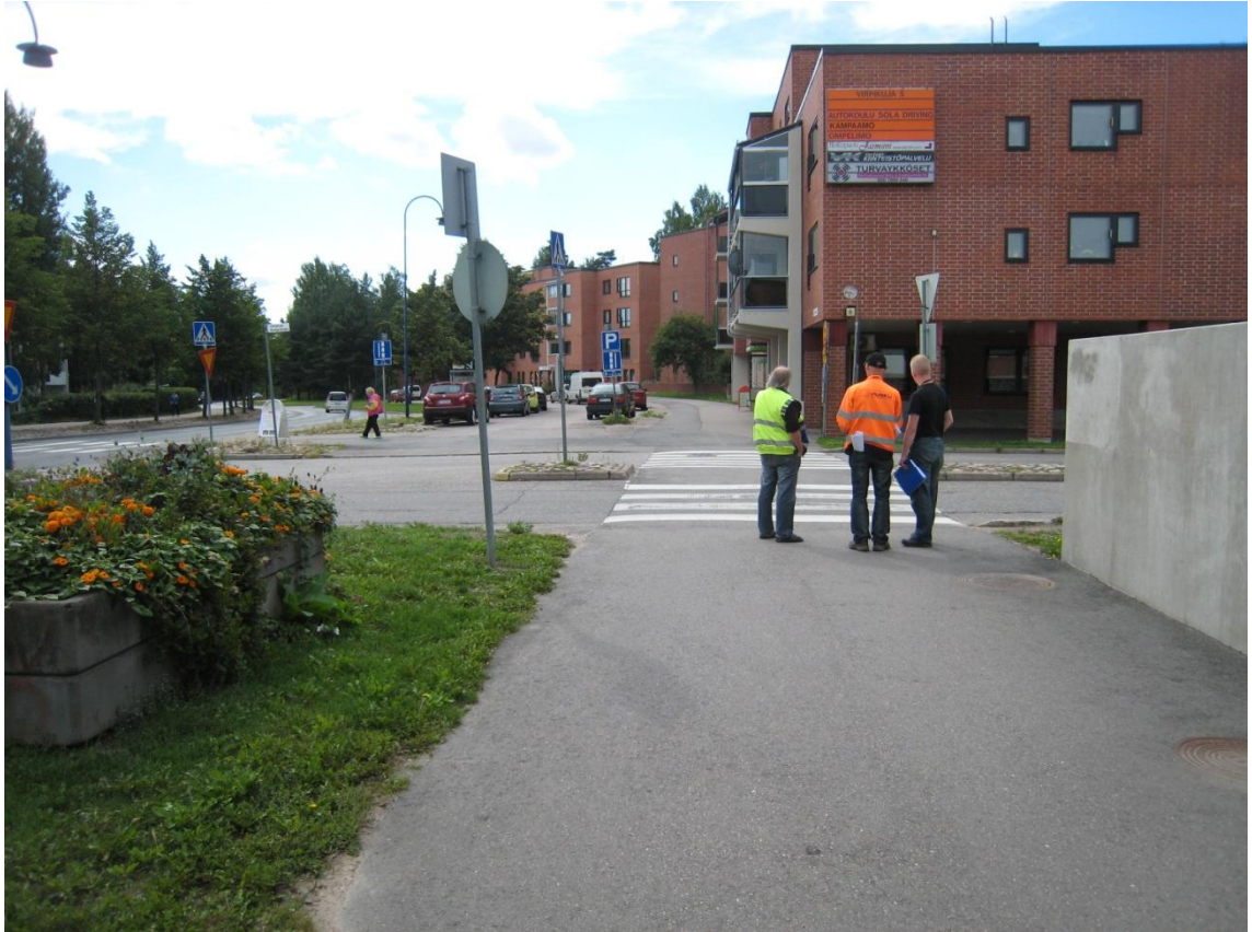
Kuva 6. Kaivulupakatselmuksessa tarkastellaan tilaajaosapuolten kanssa tulevaa kaukolämpö-kaukoreittiä.
