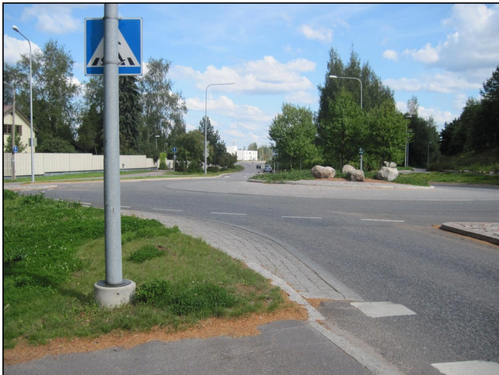
Kuva 12. Henkilöautojen poistumisgeometrian jyrkentäminen on toteutettu raskaalle liikenteelle yliajettavalla korokkeella.
