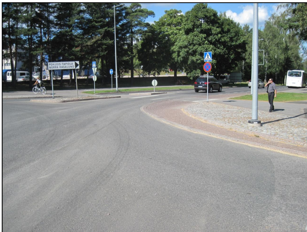
Kuva 13. Pohjantien kiertoliittymän haara Pohjois-Tapiolan suuntaan.
