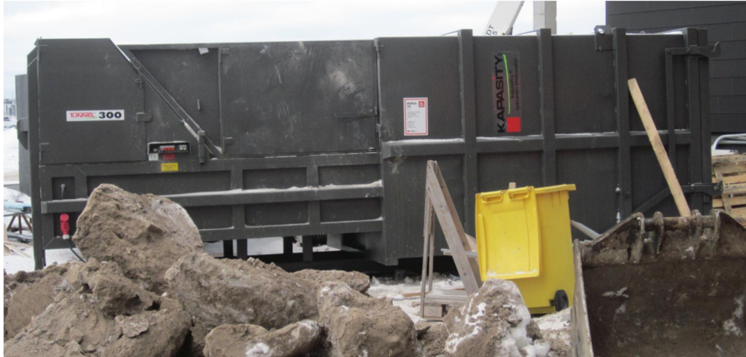
Kuvio 11. Jätepuristin työmaalla
