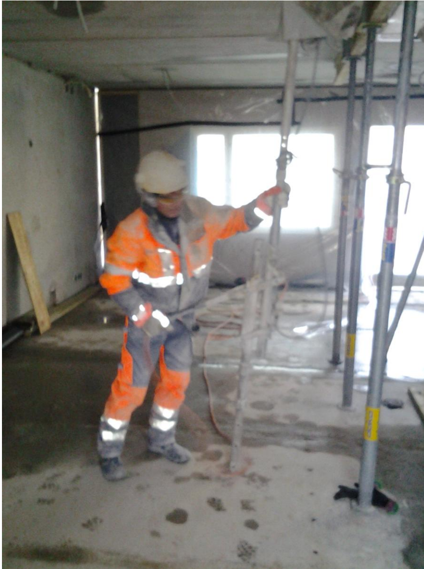
Kuva 6. Välipohjan onteloporaus käynnissä.
