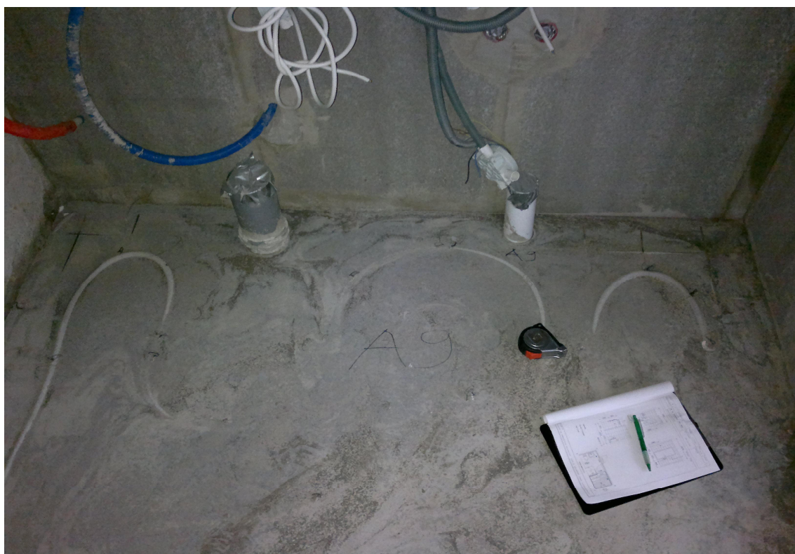
Kuva 5. Lattialämmitysputket plaanokerroksen sisällä. Lattia odottaa pintavalukerrosta (Ahola 2012.)
