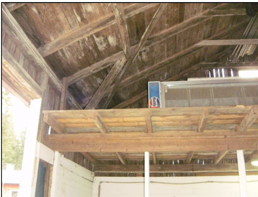
Kuva 7. Vanhan 50 - luvun tallin kattorakenne.
