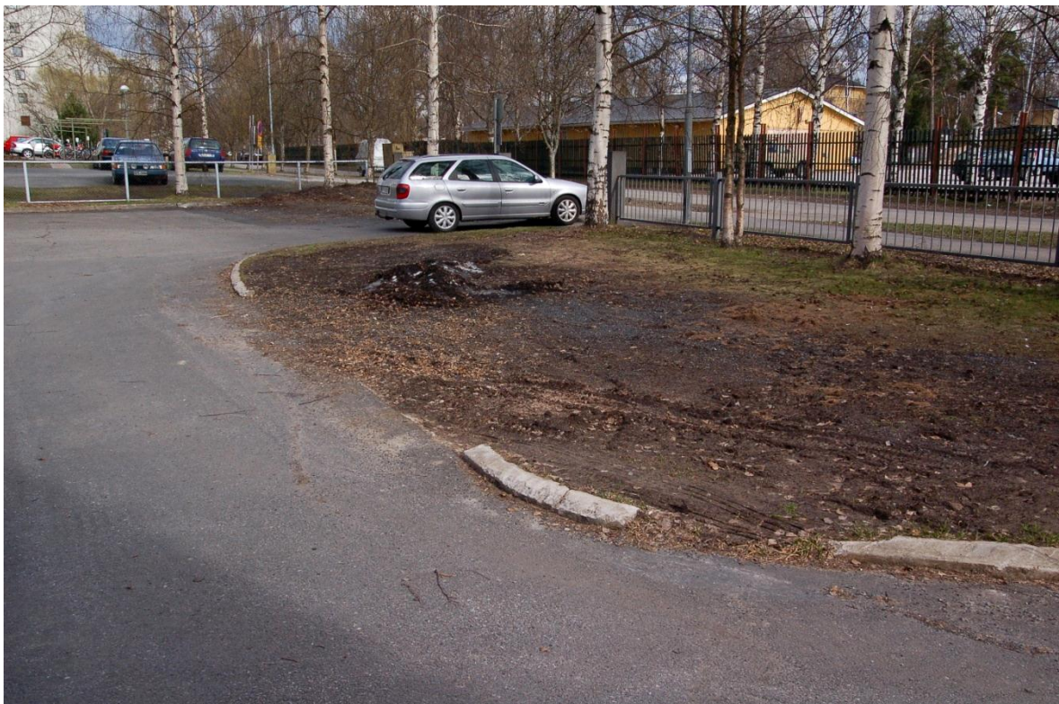
KUVA 10. Nurmikon reunakivet ovat lohkeilleet irti (L. Malmivirta 15.5.2012)
