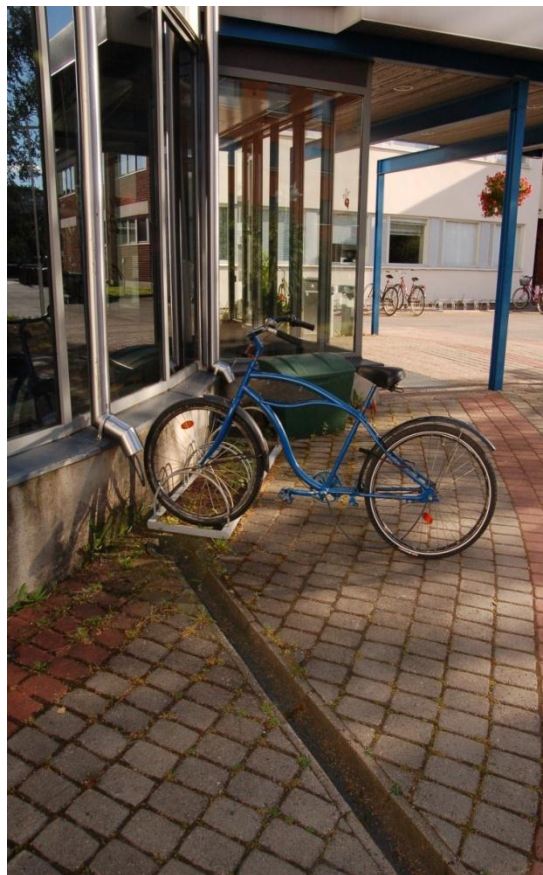
KUVA 6. Sadevesikouru on liian syvä ja jyrkkä. Polkupyörien säilytyspaikka on epäkäytännöllinen (L. Malmivirta 28.8.2012)
