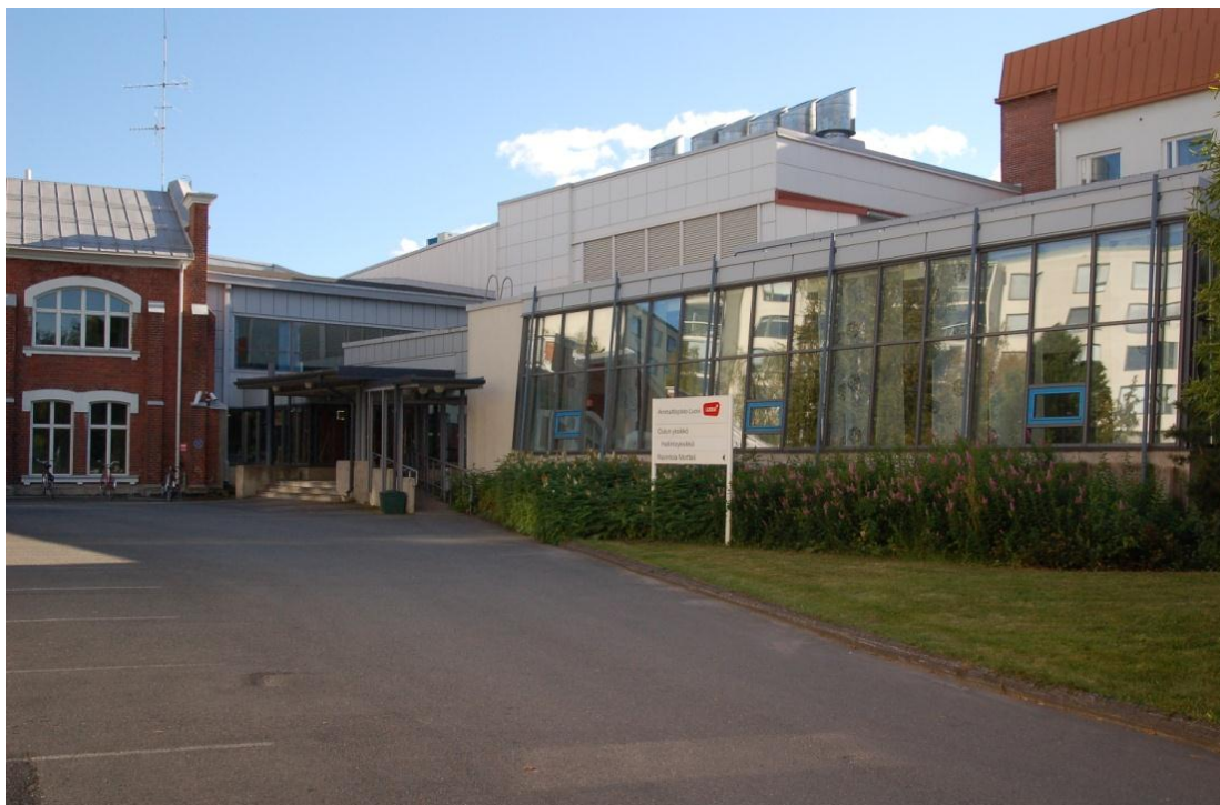
KUVA 4. Tontin pohjoispuolen sisäänkäynti ja ruokalan ikkunat (L. Malmivirta 28.8.2012)
