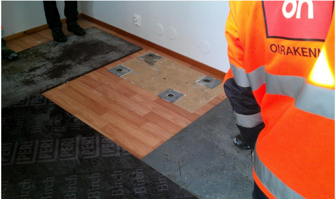
KUVA 5. Asennuspaikan ympärillä oleva kulkureitti uunille.
