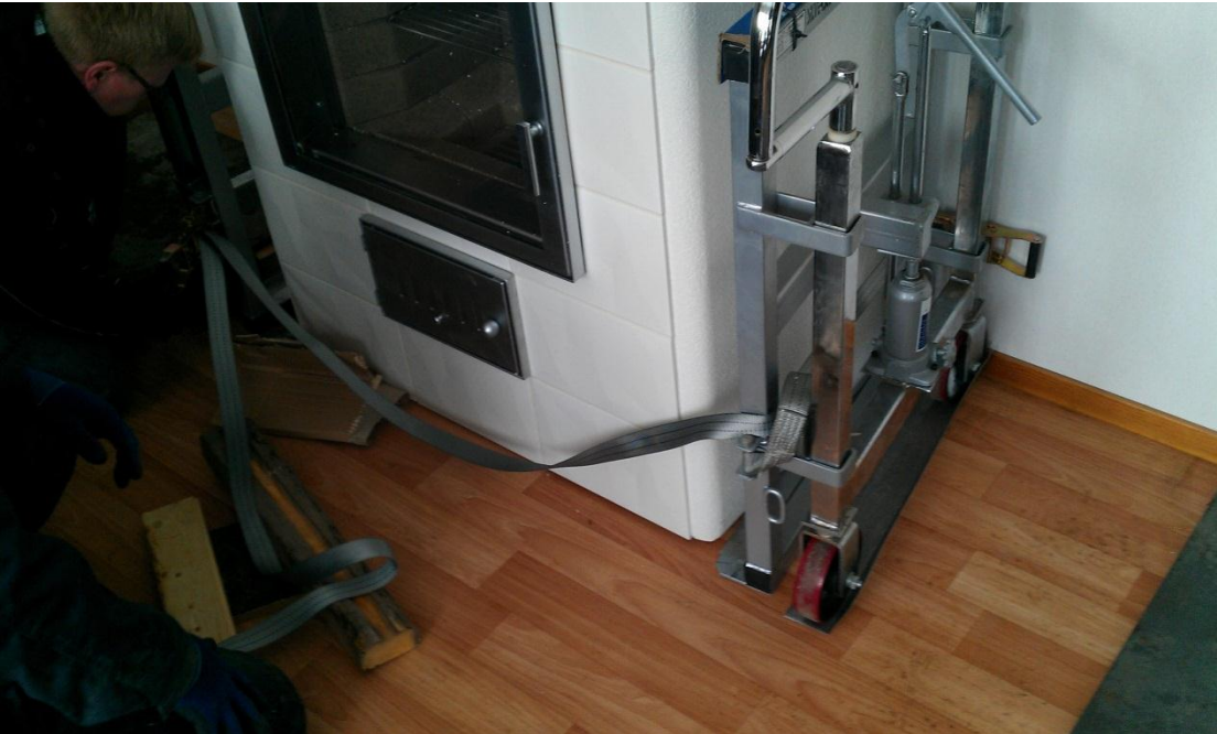
KUVA 6. Uunin paikalleen laskeminen ja tukien irrottaminen.
