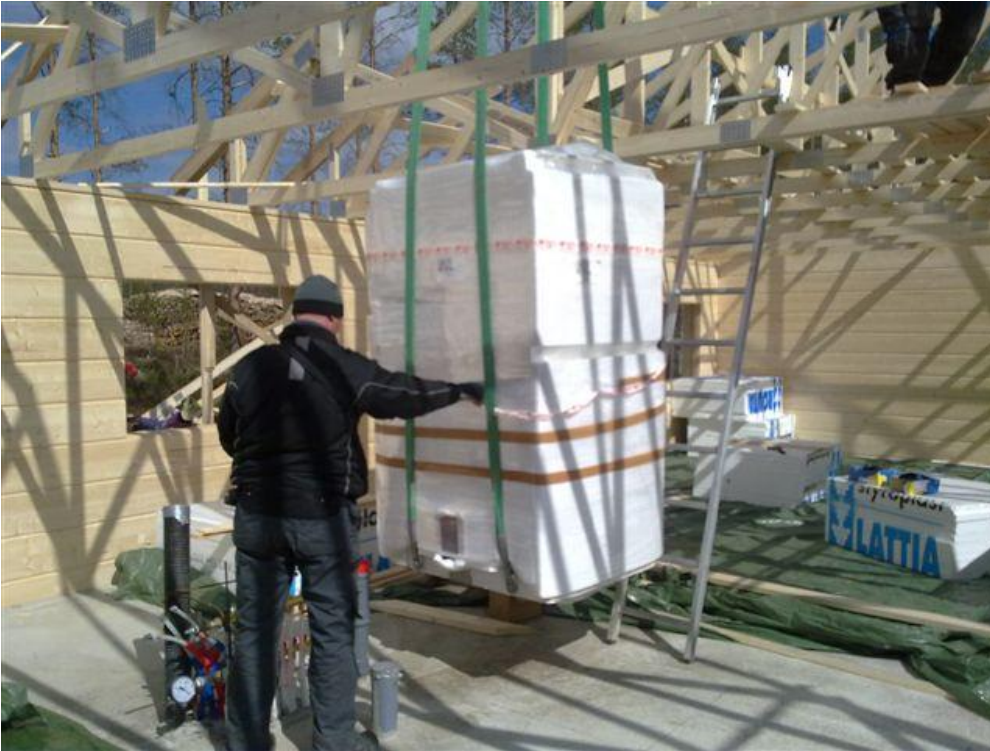
KUVA 8. Uunin paikalleen nostaminen nosturilla.
