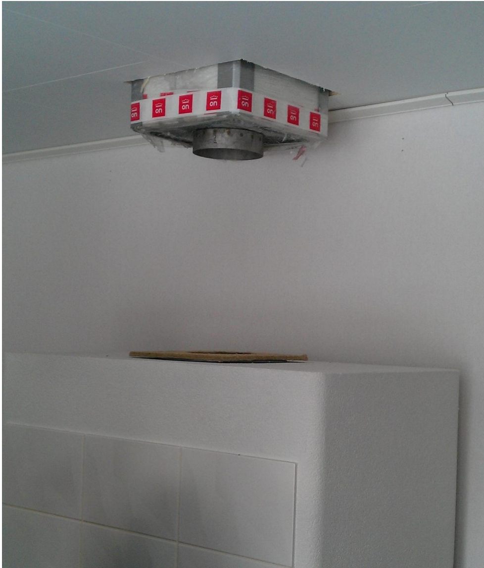
KUVA 7. Uunin piipun asennus, valmisiippu lasketaan paikalleen.
