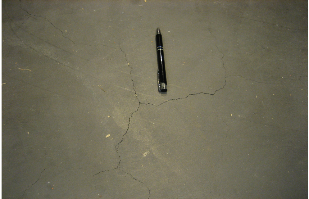
Kuva 4. Plastisen kutistumisen aiheuttamaa halkeilua.
