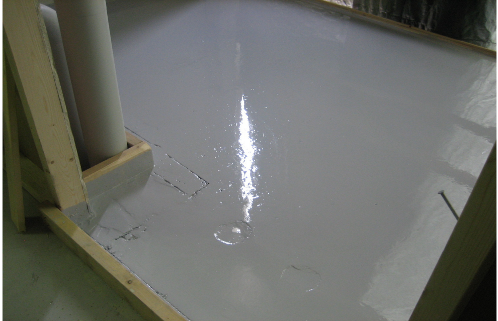
Kuva 13. Itsesiliävillä massoilla ei pystytä täyttämään suuria epätasaisuuksia lattiassa.
