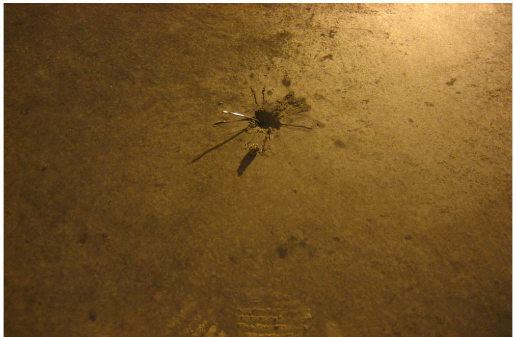
Kuva 3. Teräskuitu pystyssä valmiissa lattiapinnassa.
