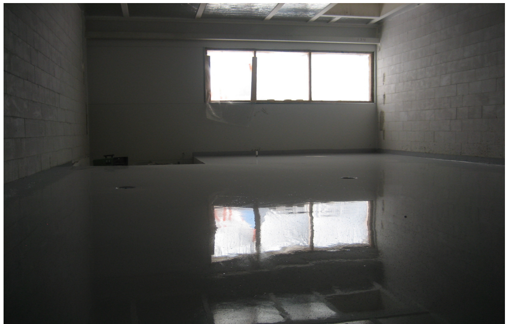
Kuva 15. Luonnonvaloa vasten pinnoitteessa näkyy pienimmätkin virheet.
