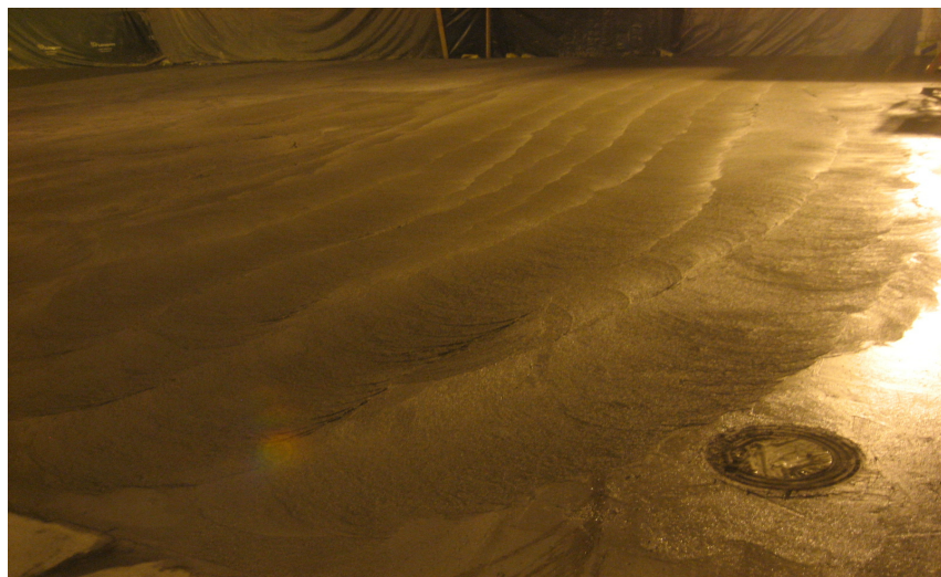
Kuva 8. Ensimmäinen konehierto suoritettu noin 3 tunnin kuluttua valusta.
