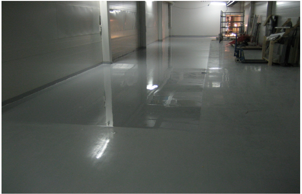
Kuva 14. Kuplineen pinnoitteen paikkausjälki.
