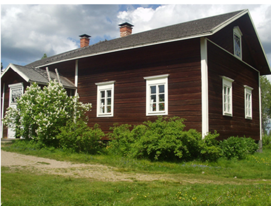
Kuva 4. 1900-luvun perinteinen asuinrakennus. Hirsitalo (Lähde Vuolle-Apiala, R.)
