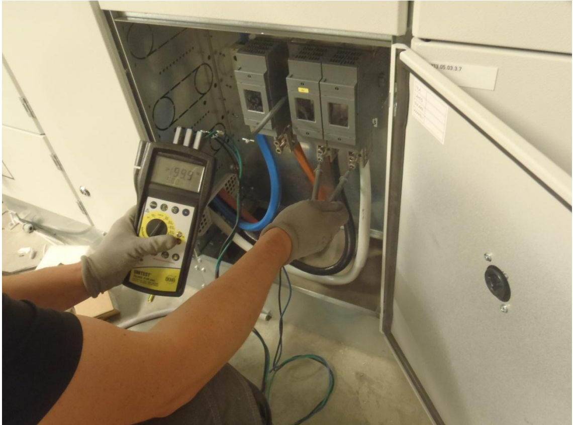
Kuva 2. Eristysresistanssin mittaus UNITEST TELARIS –mittarilla.
