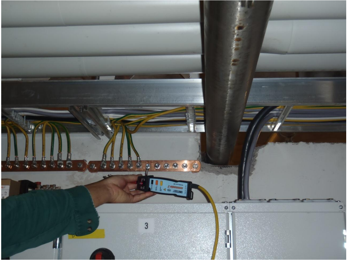
Kuva 3. Suojajohtimen jatkuvuusmittaus keskuksen päästä.
