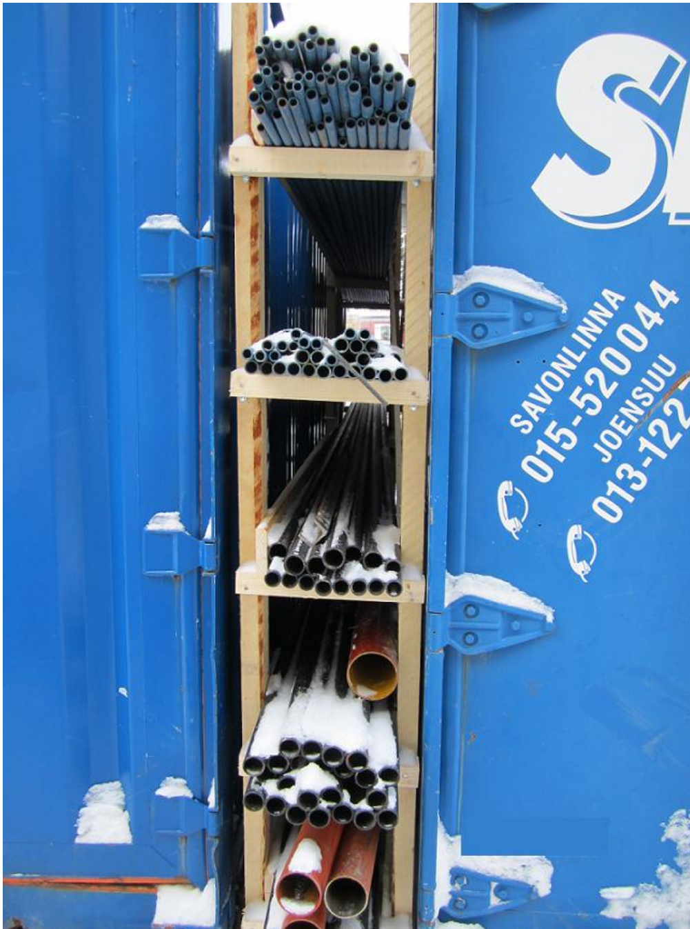
KUVA 8. Putkien varastointi putkihyllyihin
