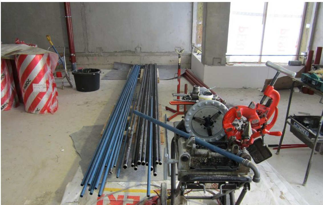
Putket varastoituna lähelle kierteityskonetta
