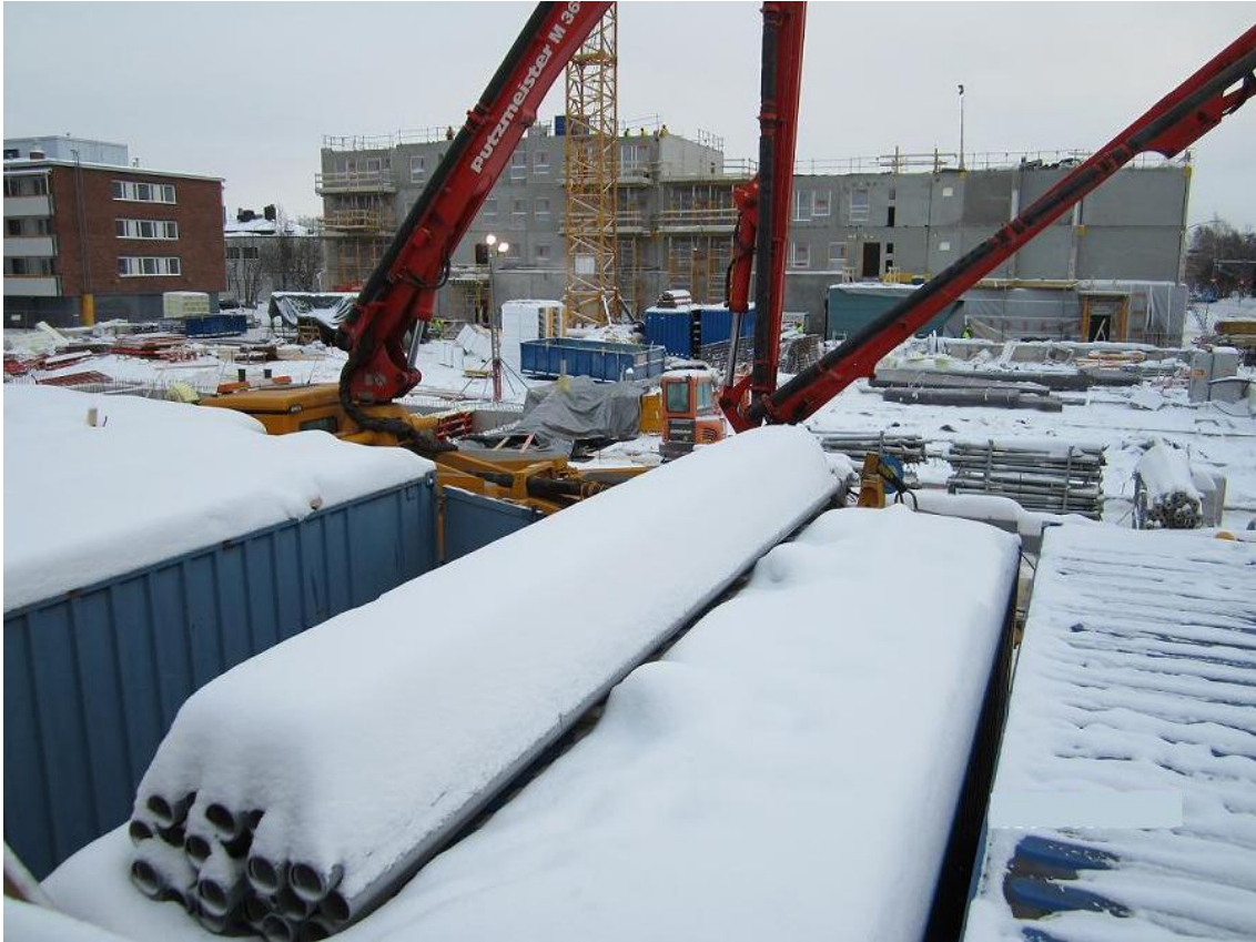
KUVA 5. Merikonttien sijainti työmaalla
