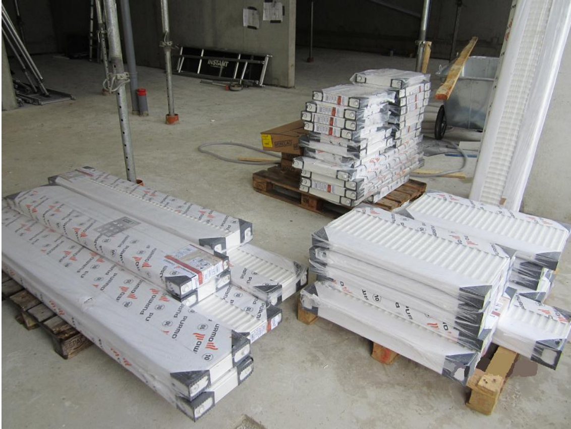
KUVA 9. Materiaalin varastointi lähelle asennuskohdetta
