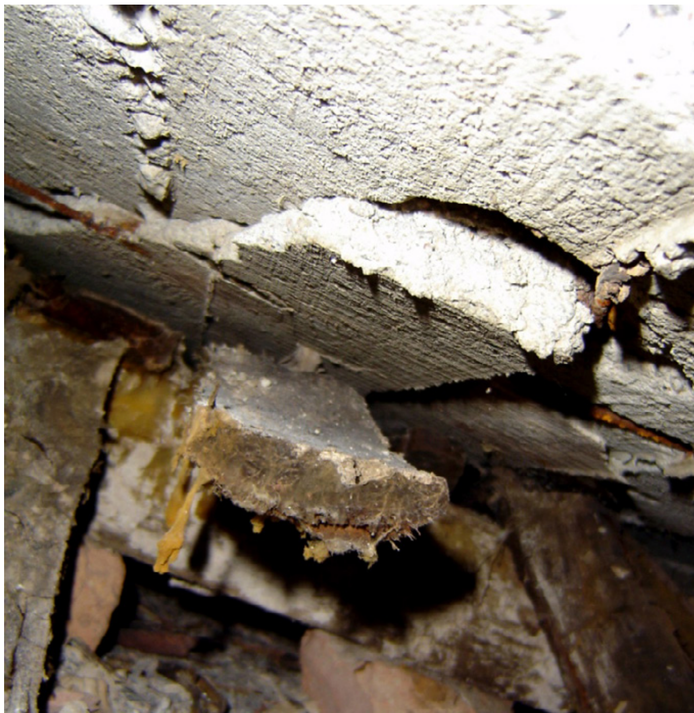
Överflödigt fukt i byggnadskonstruktioner kan förorsaka kemisk och biologisk nedbrytning av byggnadsmaterial.
