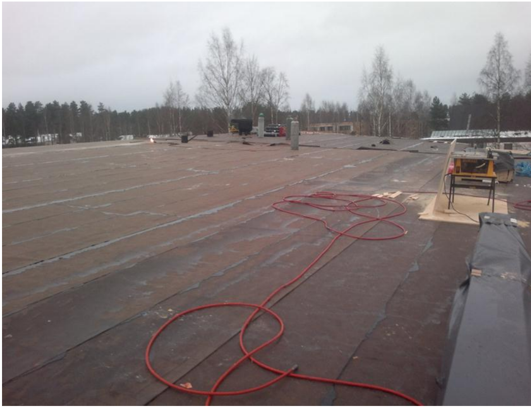
Kuva 5. Yleiskuva työmaan järjestyksestä.
