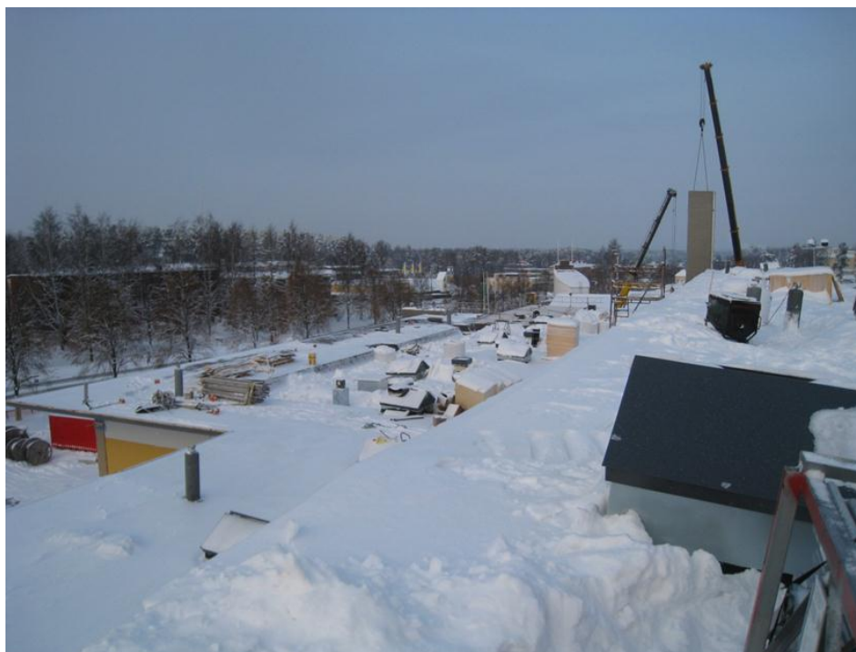
Kuva 3. Kattotyömaa Mäntyharjulla talviolosuhteissa.
