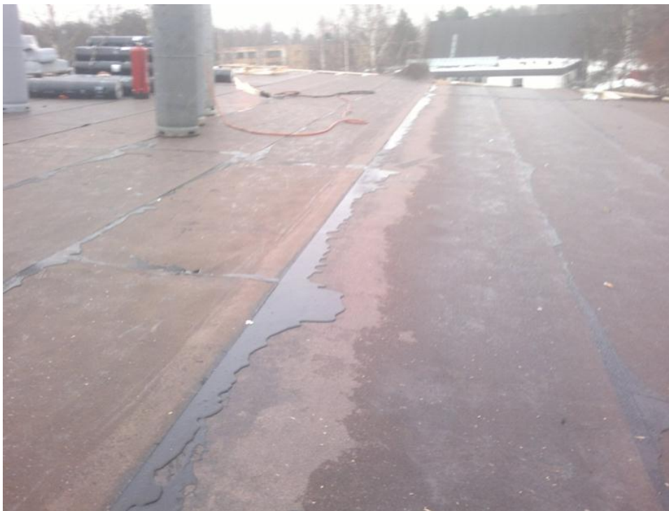
Kuva 14. Valmis bitumisauma.
