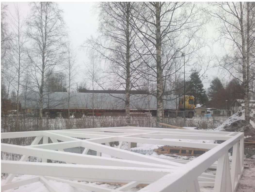
Kuva 2. Kattoelementtien kuljetus Alajärven uimahallin työmaalle.
