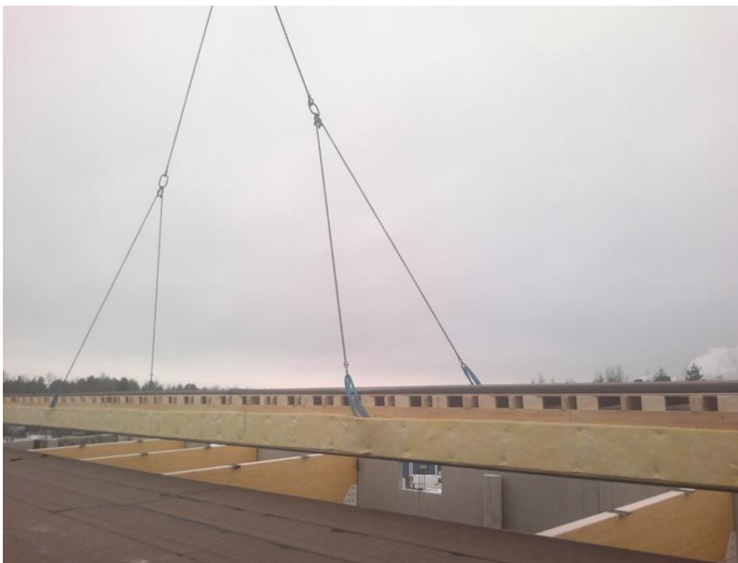
Kuva 7. Elementin kiinnittäminen ketjuilla ja köysillä.
