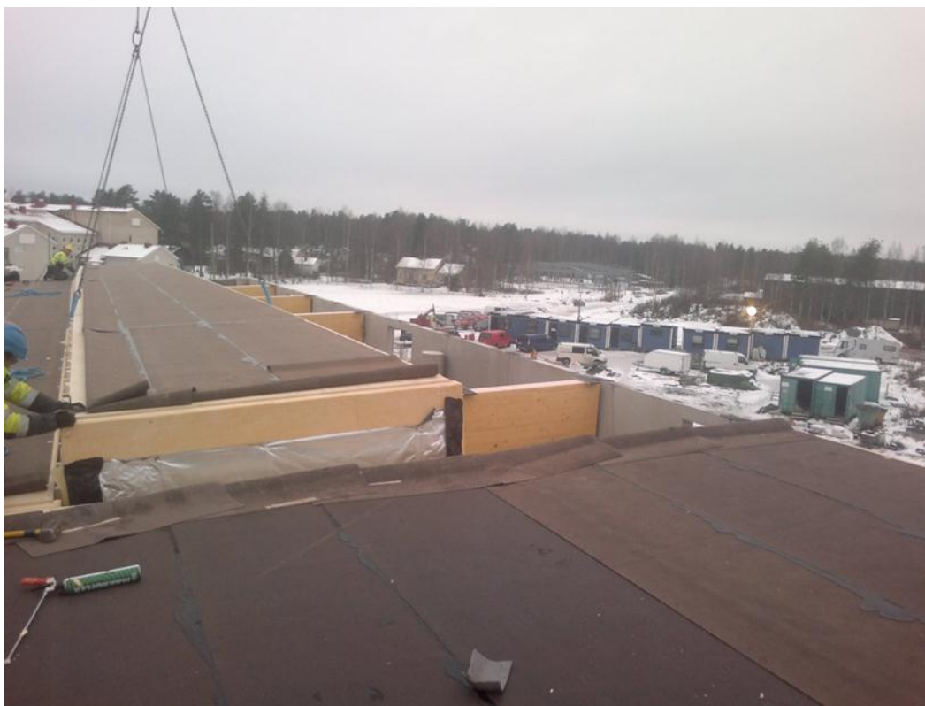
Kuva 6. Yli 20 metriä pitkän elementin asennus Alajärven uimahallin työmaalla.
