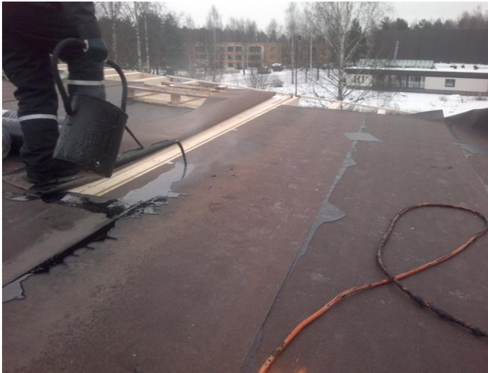
Kuva 13. Sulanut bitumi kaadetaan liimattavaan alustaan.
