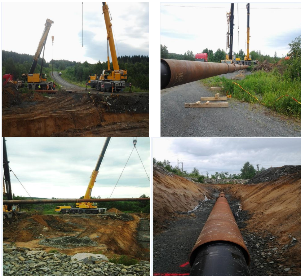
Kuva 14. Kiertovesilinjan nostotyöt Jaakonlammen työpisteessä. Kuva: Pekka Nissinen 2012
