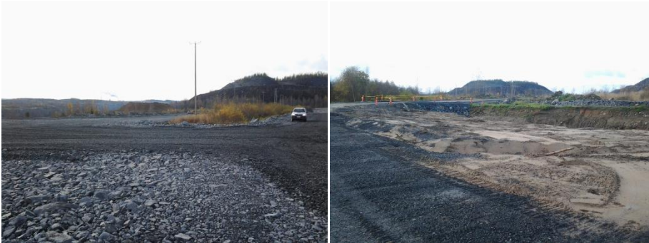
Kuva 18. Valmis työmaa. Kuva: Pekka Nissinen 2012
