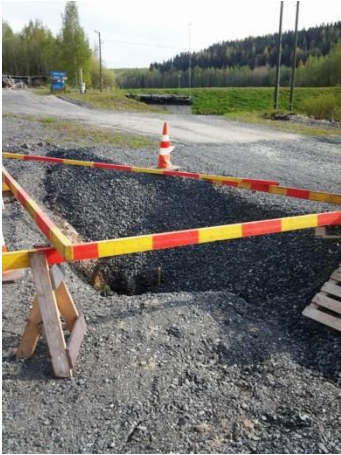
Kuva 10. Kevään 2012 aikana kaivettu koekuoppa kiertovesilinjalla Jaakonlammen työpisteessä. Kuva: Pekka Nissinen 2012
