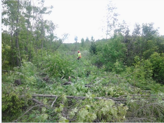
Kuva 11. Putkilinjojen raivaustyöt käynnissä. Kuva: Pekka Nissinen 2012
