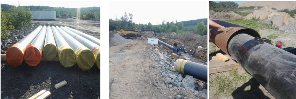
Kuva 13. Kiertovesilinjan muovityöt käynnissä. Kuva: Pekka Nissinen 2012
