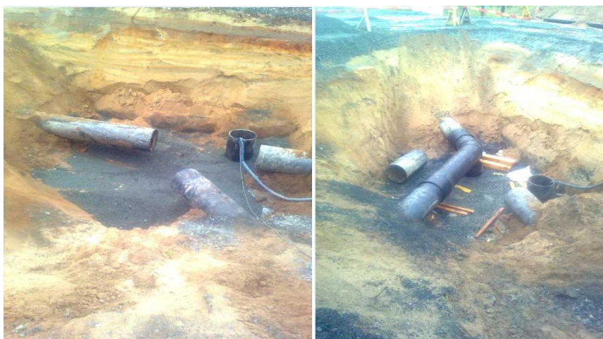
Kuva 16. Uuden ja vanhan kiertovesilinjan sähkömuhviliitos Jaakonlammen työpisenteellä. Kuva: Pekka Nissinen 2012
