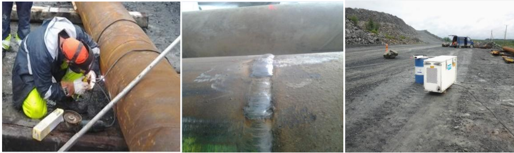
Kuva 15. Kuvia rikastushiekkaputkien hitsaustöistä. Kuvat: Pekka Nissinen 2012
