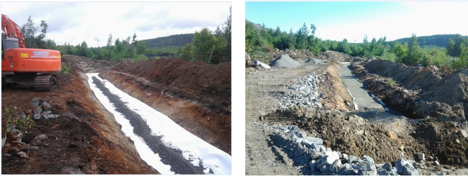
Kuva 12. Kiertovesilinjan putkiarinan teko alkamassa ja valmiina: Kuva Pekka Nissinen 2012
