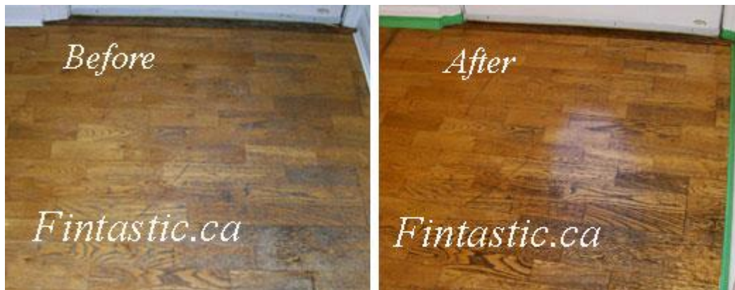
Kuva 11. Lattian käsittely ilman hiontaa (14).
