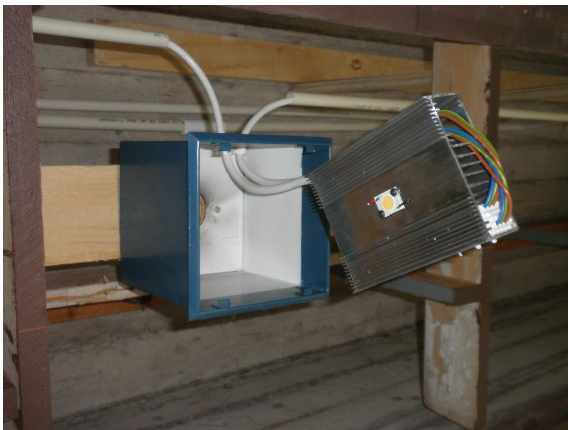
Kuva 18. Valaisimen korjaus uudella valonlähteellä
