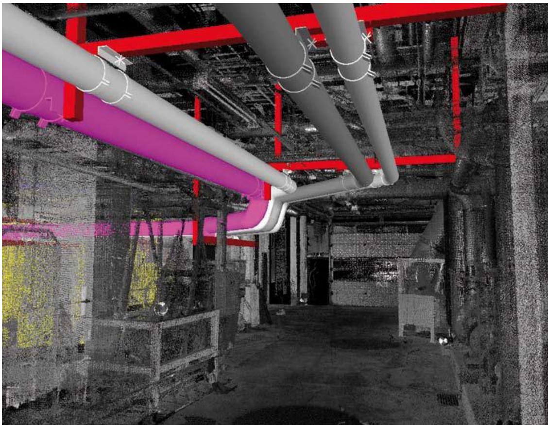
Kuva 13. Pistepilvimallinnus ja putkisto [13, s. 2.]
