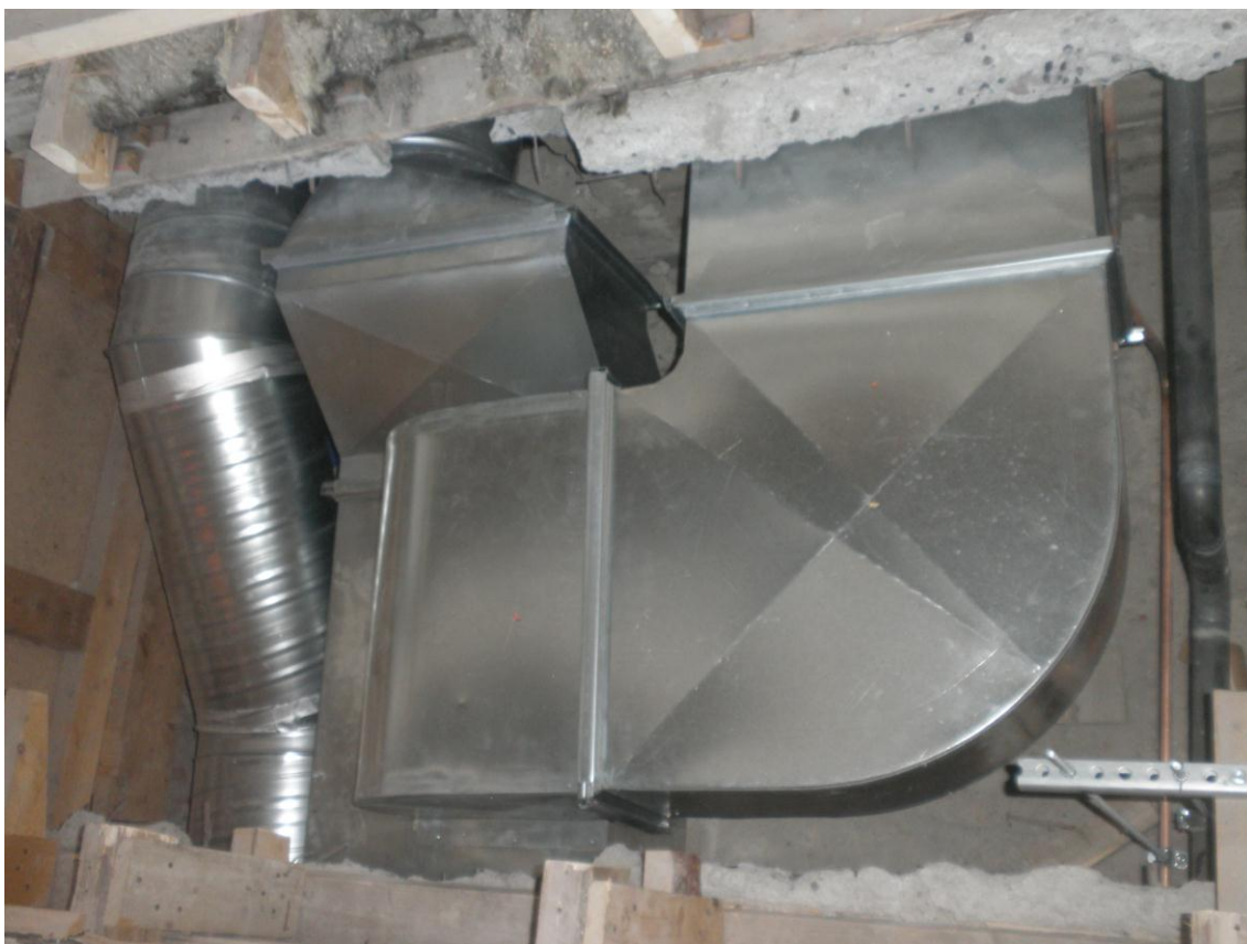
Kuva 14. IV-kanaviston läpiviennit
