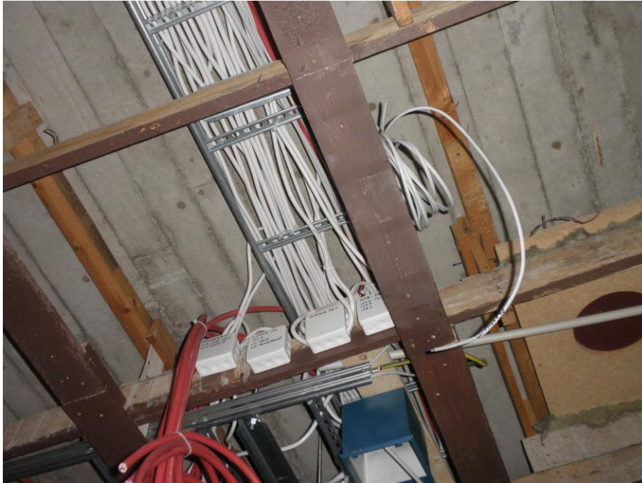
Kuva 16. Johtoteitten ja jakorasioitten sijoitus rakenteisiin
