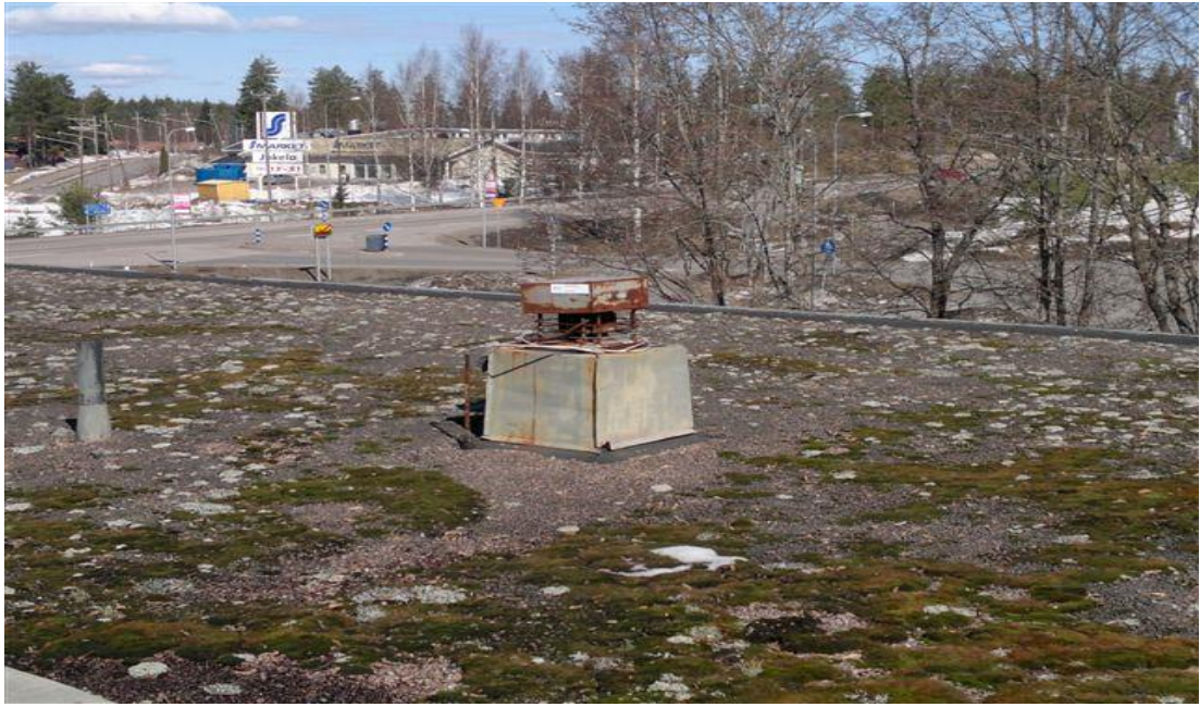
Kuva 4. Loivan vesikaton saneeraus. Alkutilanne (Sokura, 2011)
