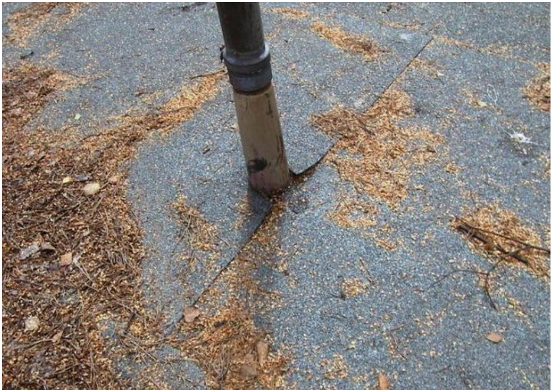
Kuva 17. Saumat ja ylösnostot tulee olla kunnossa (Sisäilmayhdistys 2013.)
