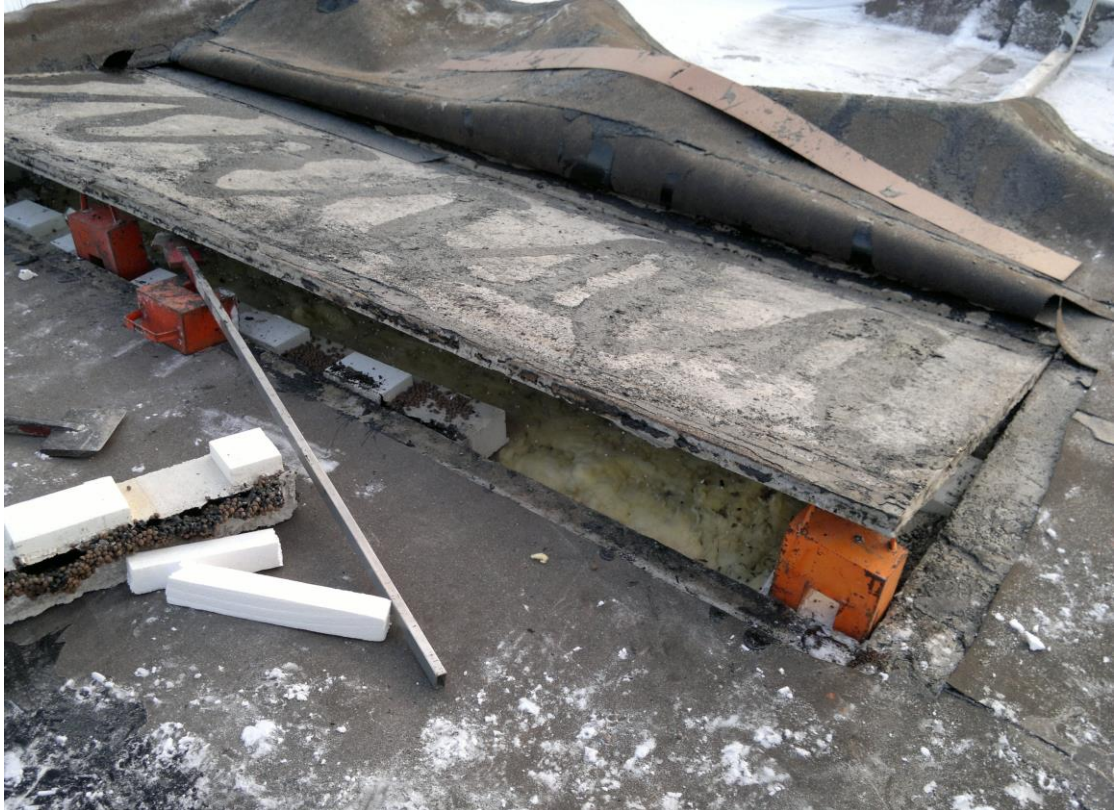
Kuva 19. Vanha yläpohjarakenne, Nilcon-elementin kuorilaatta (Laurinanti, 2011.)
