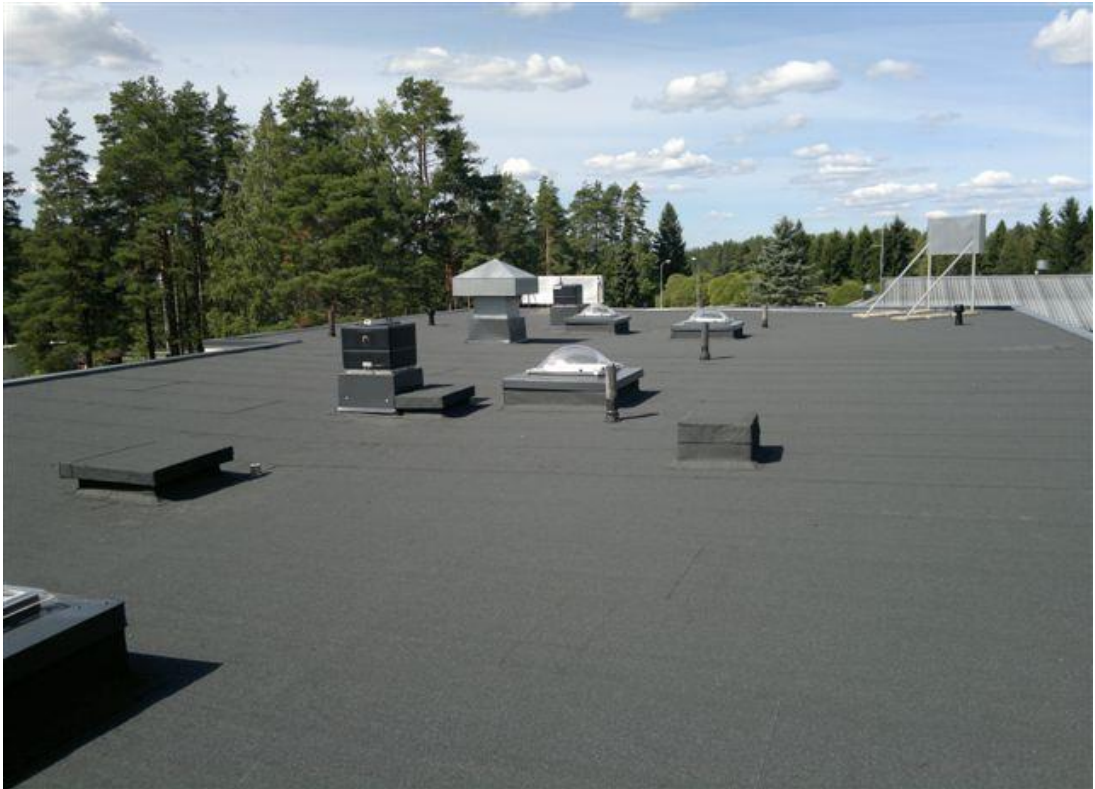
Kuva 8. Loivan vesikaton saneeraus. Lopputilanne (Sokura, 2008)
