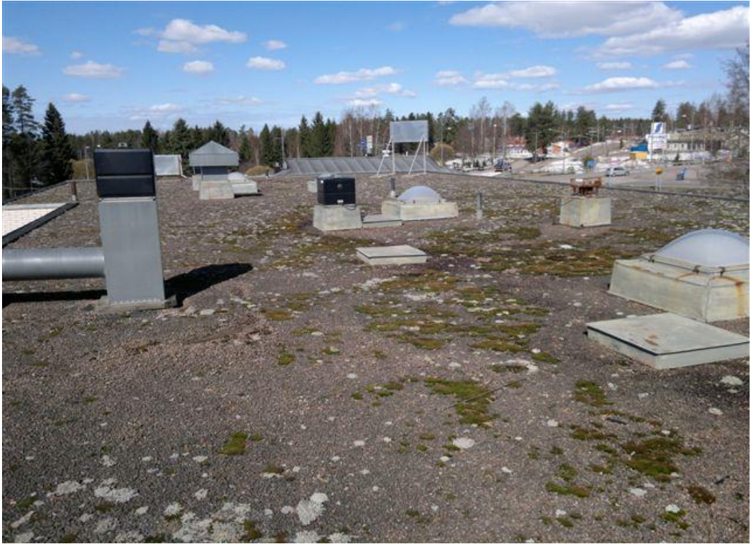
Kuva 7. Loivan vesikaton saneeraus. Alkutilanne (Sokura, 2008)
