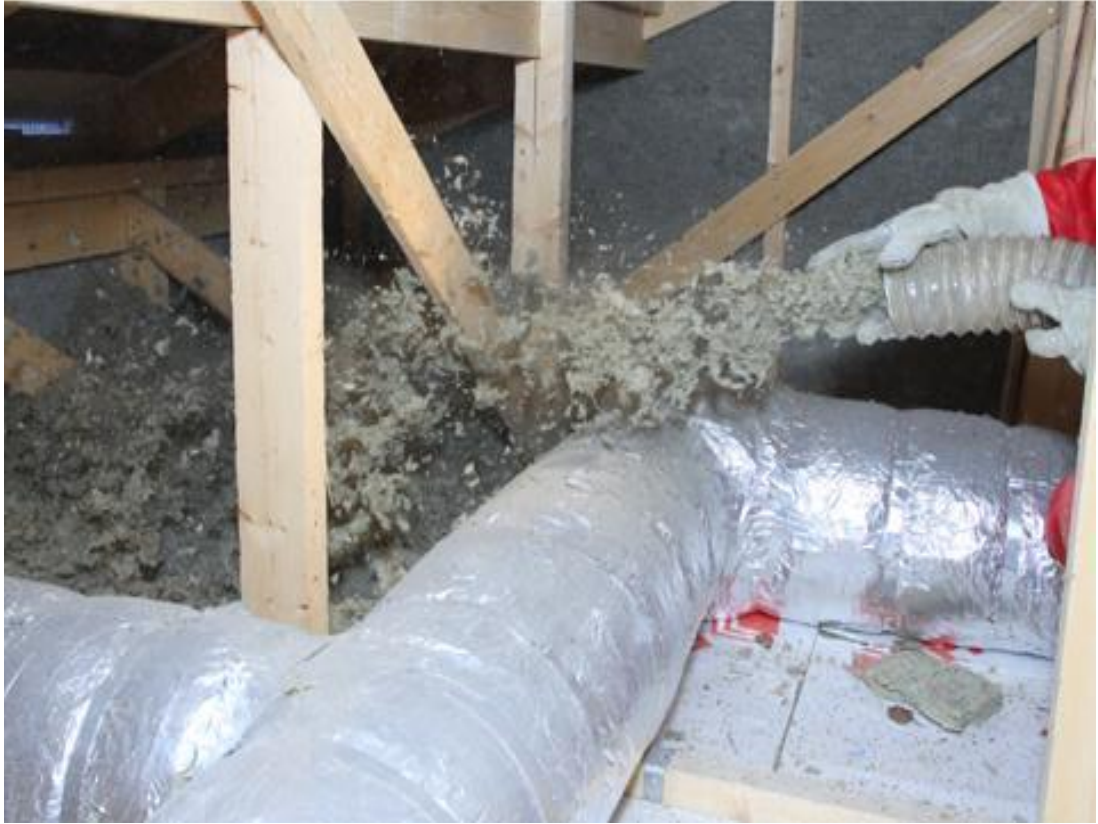
Kuva 11. Yläpohjan lisälämmöneristys (Yläpohjan lisälämmöneristys ja kustannukset 2009.)
