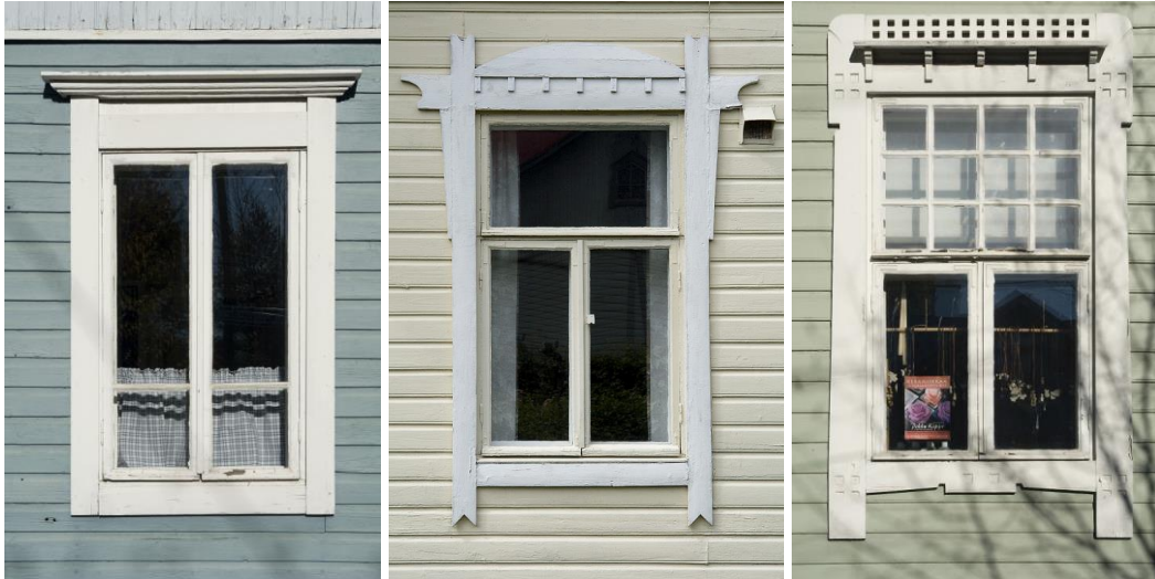
Kuva 15. Kuljettajan kaupunginosan rakennusten ikkunoita. Vasemmalla on pelkistetty klassistinen ikkuna, kun taas keskellä ja oikealla olevissa ikkunoissa on kansallisromanttisia piirteitä: kaarevia muotoja, yksityiskohtia ja pieniruutuinen ikkuna. (Wasastjerna, 2010)
