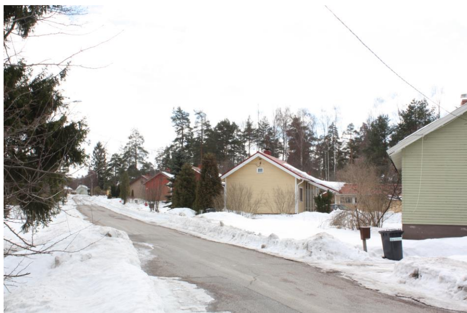
Kuva 32. Sudeetin ominaispiirteet ovat säilyneet hyvin tähän päivään asti sekä rakennusten että asemakaavan osalta. (Niinipuu, 2012)
