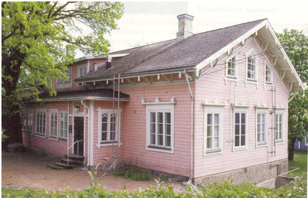
Kuva 3. Sveitsiläis- eli nikkarityylinen kunnantupa Paraisilla 1870-luvulta. Väritys ei ole alkuperäinen. (Curatio Turunmaan korjausrakentamisyhdistys Ry 2011: 30, Seppälä, A-L)
