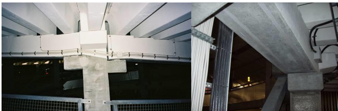
KUVA 2. Pysäköintihallin vahvistettu palkki (Täljsten ym. 2011, 30)
