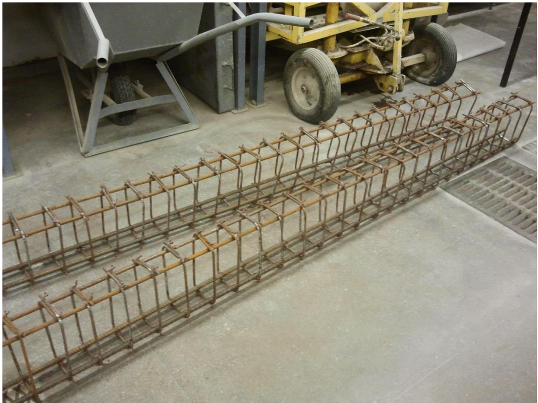
KUVA 23. Palkkien raudoitus. Valokuva Atte Heiskanen
