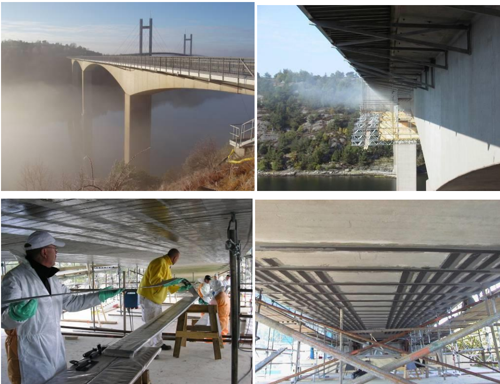
KUVA 3. Sillan vahvistamisen vaiheet (Täljsten ym. 2011, 31)
