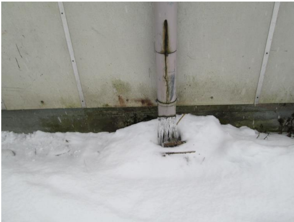
KUVA 13: Mineriittilevyssä ja sokkelissa sammalkasvustoa
