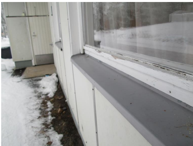
KUVA 39: Ikkunapuitteen maalin irtoamista ulkopuolelta
