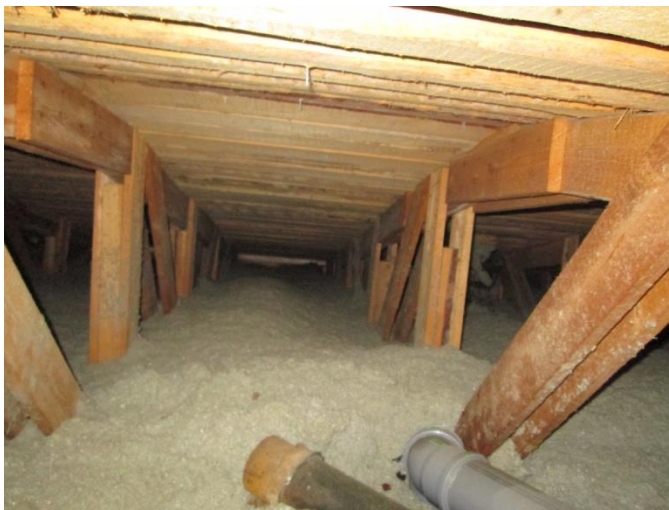
KUVA 22: Kattotuolien runkorakenteet on tehty erimittaisista pätkistä sahatavaraa
