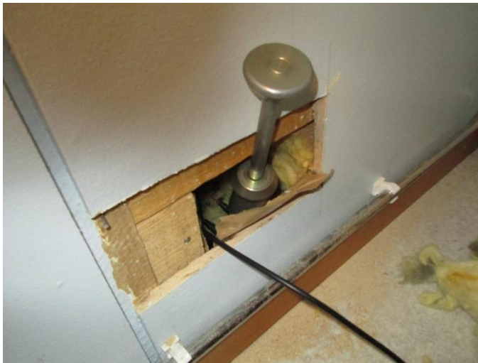
KUVA 18: Avattu seinärakenne ja alapuun kosteuden mittaus piikkimittarilla
