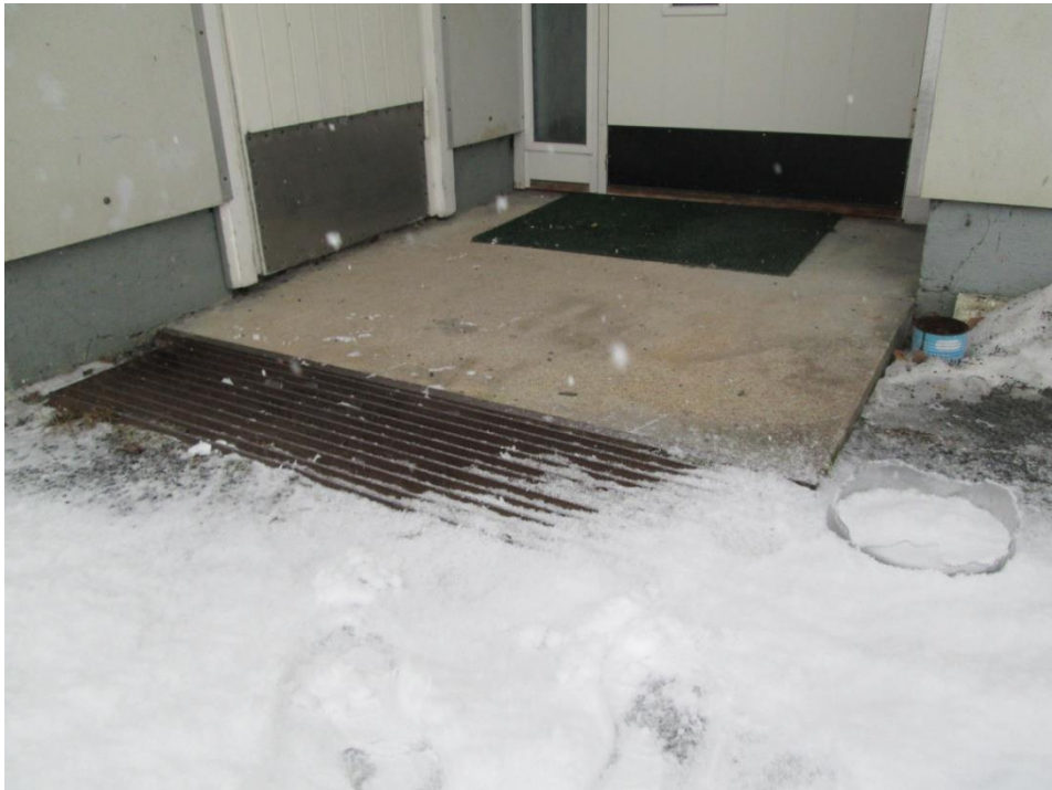
KUVA 7: Lattianpinta on lähes samalla tasolla maanpinnan kanssa liikennealueella
