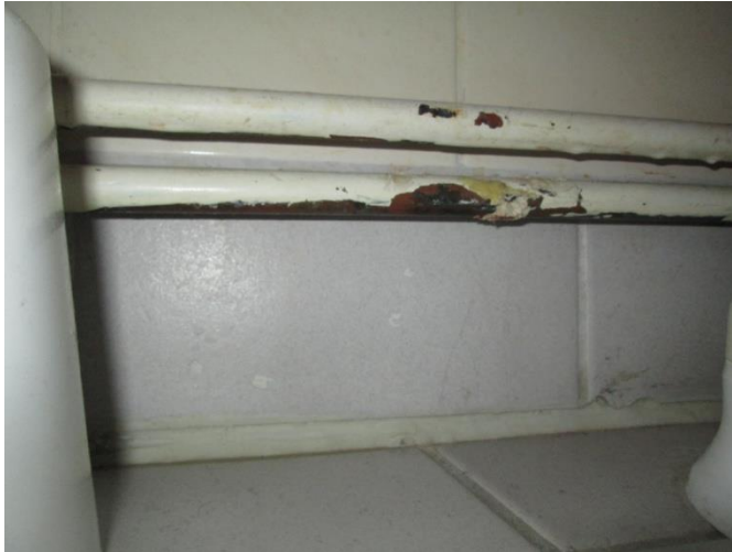
KUVA 48: Käyttövesiputken pinnoitusvaurio
