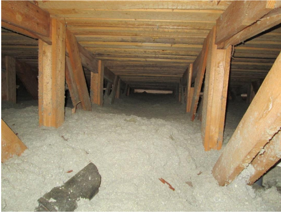
KUVA 21: Tuuletusraot, vanha iv putki, kaarnapaloja ja selluvillan epätasaisuus näkyvillä
