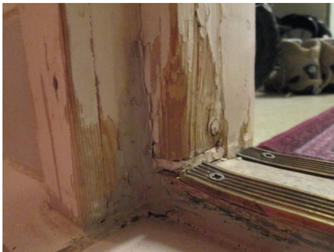
KUVA 18: Märkätilan tummunut kynnyks
