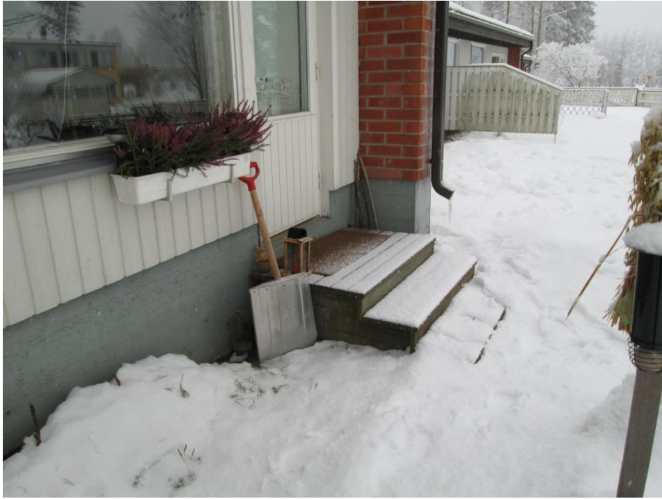
KUVA 8: Sokkelin on pihan puolella riittävän korkealla
