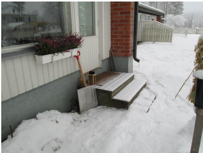
KUVA 52: Takapihan puinen ulkoporras
