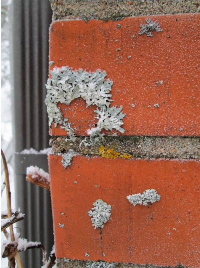
KUVA 11: Sammalkasvustoa tiiliseinässä
