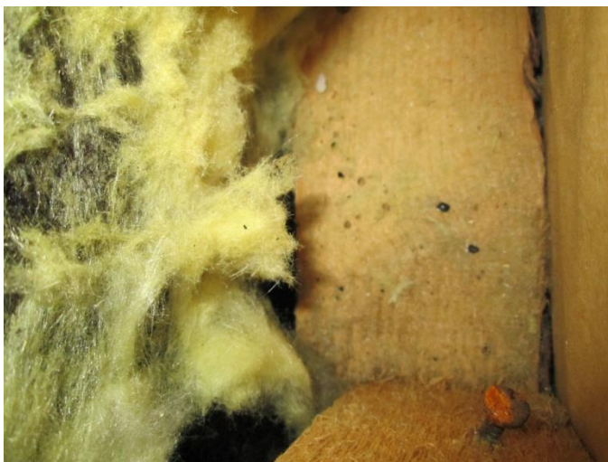
KUVA 20: Alajuoksun poikkeama piirustuksista
