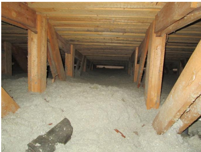
KUVA 14: Tuuletusraot, vanha iv putki, kaarnapaloja ja selluvillan epätasaisuus näkyvillä
