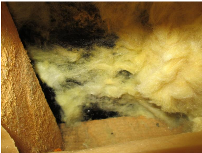
KUVA 19: Avatun seinärakenteen materiaalit ovat terveen näköiset
