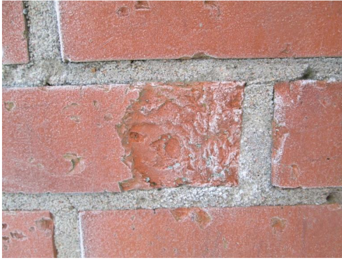
KUVA 9: Tiiliseinän pakkasrapautuma
