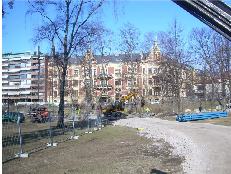
KUVIO 1. Kanaalinlouhintatyömaa kaivopuistossa vuonna 2010
