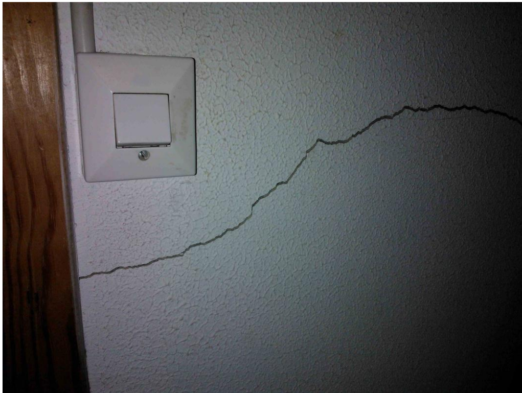
Kuva 11. Takan taustaseinä (Marti )
