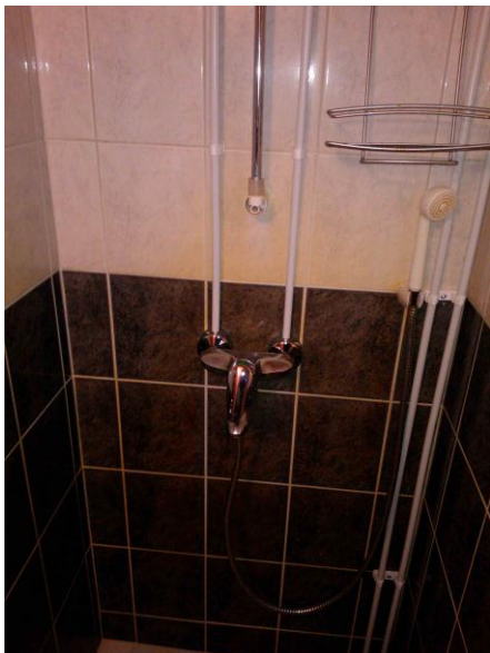
Kuva 20. Kylpyhuone on uusittu ja pintavedot samassa yhteydessä
