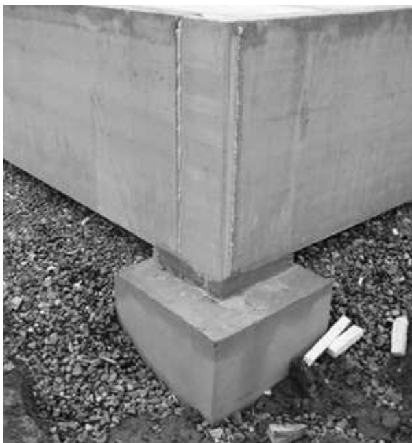
Kuva 5. Valmis pilariantura, sekä juotosvaletut sokkelielementit.
