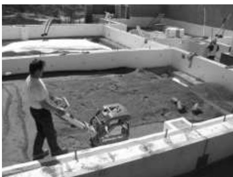
Kuva 2. Sisäpuolisen täytön tiivistys tärylevyllä
