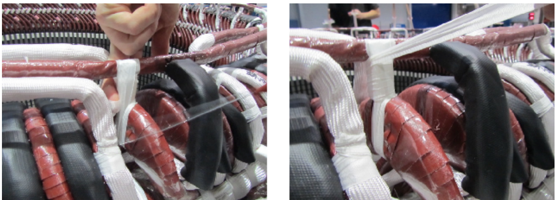
Kuva 18. Tukipalan sidontaa polyesterinauhalla ensin pitkittäin väliyhdistäjän ja vyyhden pään ympäri, sen jälkeen laminaattipalan ympärille poikittain
