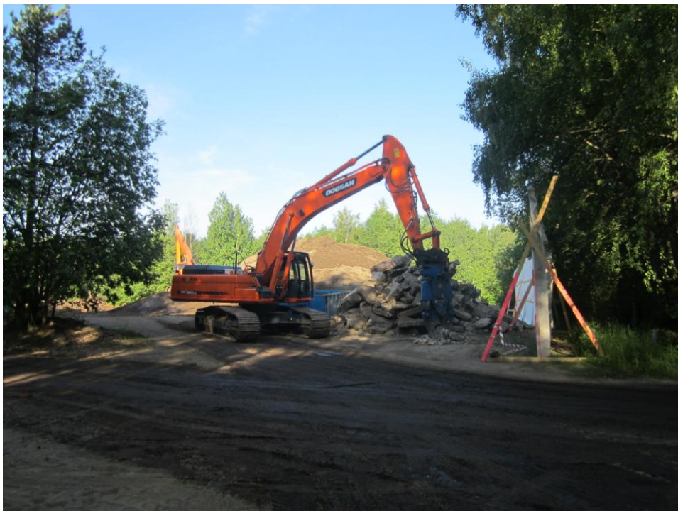
Kuva 12. Betonin pulverointi.
