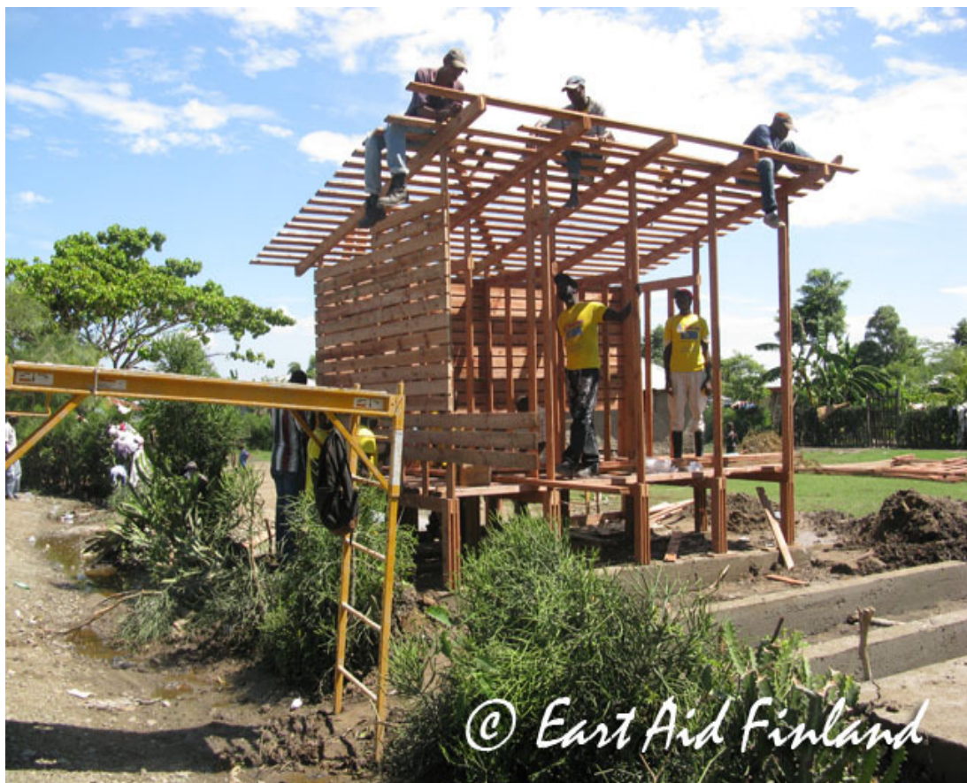
KUVA 5: Perinteistä rakentamista Haitissa
