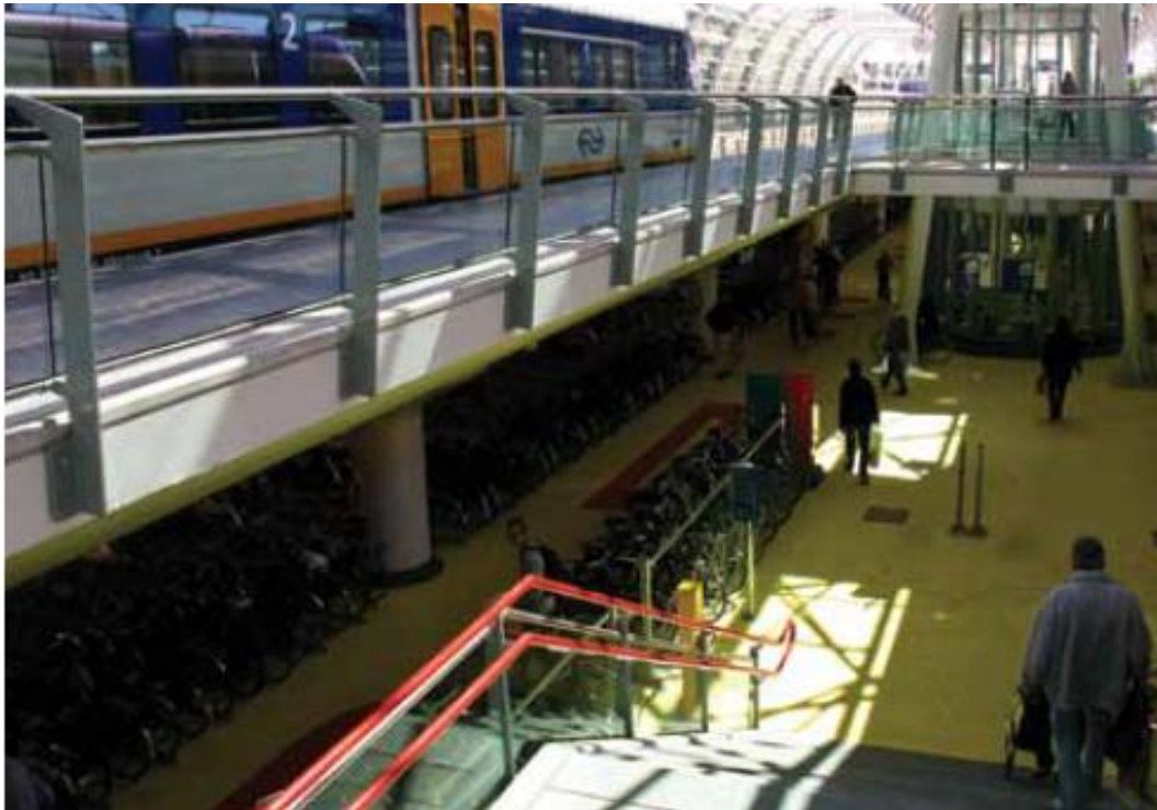
KUVA 14. Houtenin rautatieasemalla on rakennettu ilmainen pyöräpysäköinti suoraan raiteiden alapuolelle (9, s. 188)
