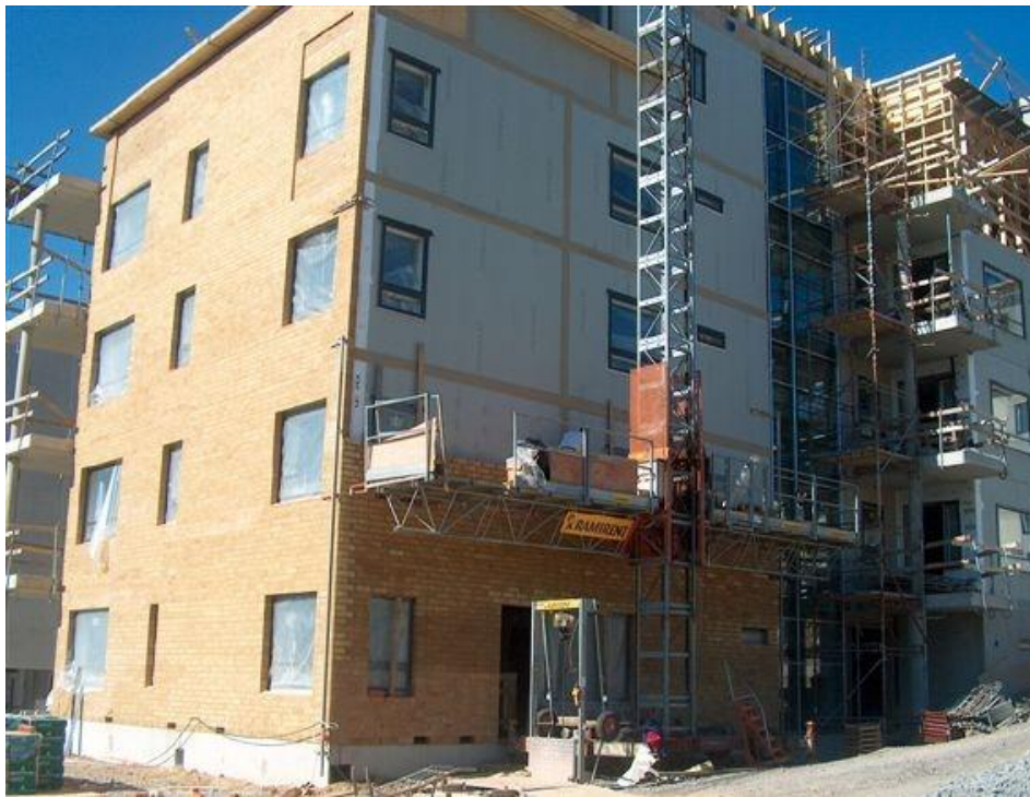
Kuva 6. Julkisivumuurausta mastolavalta. [14.]
