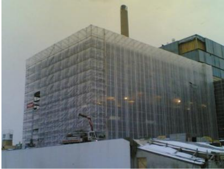
Kuva 5. Huputetut rakennustelineet Salmisaarenaukiolla Helsingissä. [11.]
