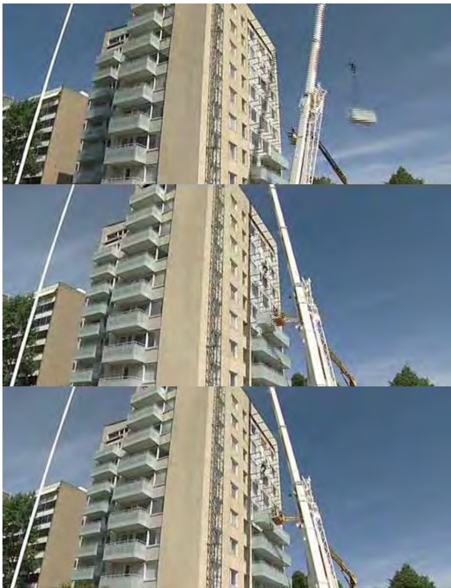
Kuva 16. Producta-parvekkeen asennus. [39.]
