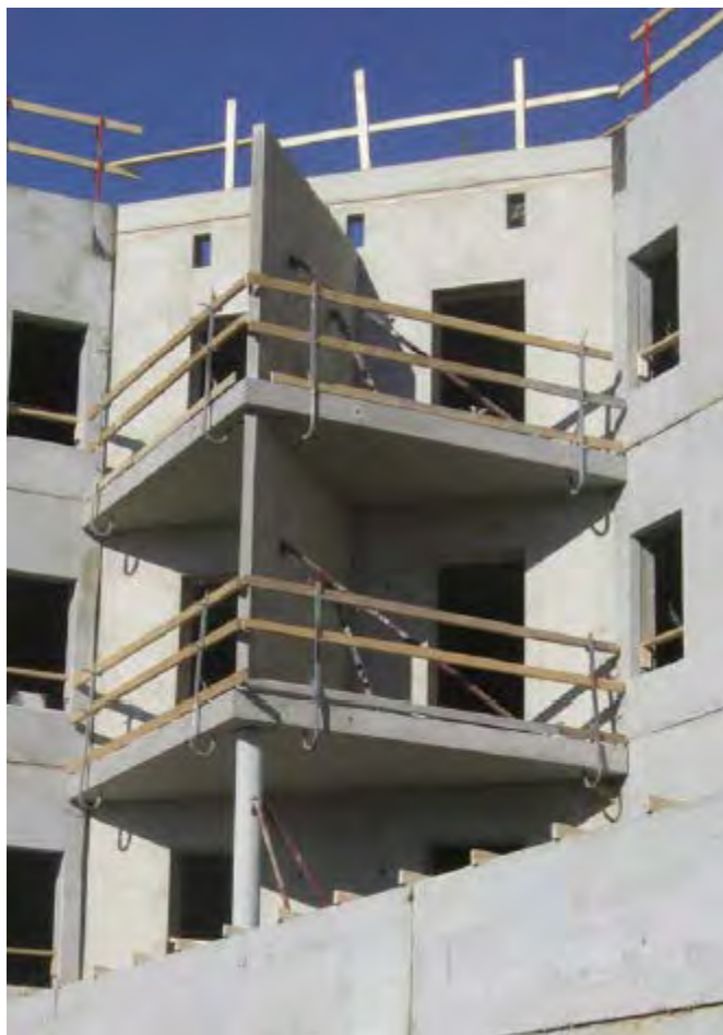
Kuva 17. Pilarilla ja pielellä tuettu parveke. [1]
