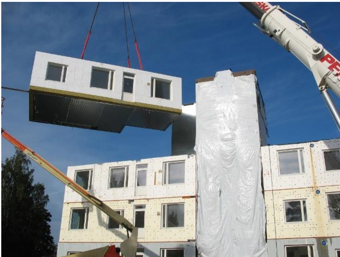
Kuva 3.2. Myllypuron moduulien asennus (NEAPO:n www-sivut, 4)
