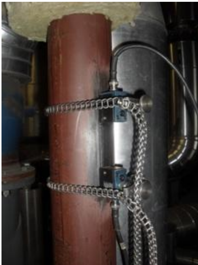
Kuva 5.1.3. Ultraäänimittarin mittaussanturit (Olli-Pekka Vanhala)
