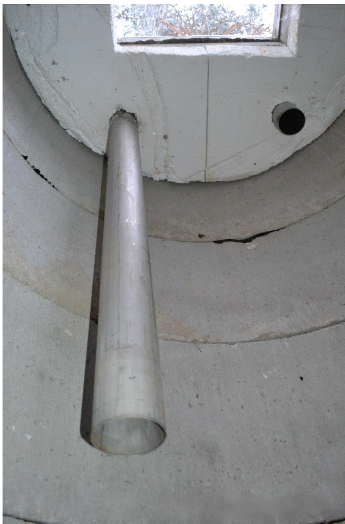
Kuva 10 Kaivo sisältäpäin (Kosunen 9.1.2013.)
