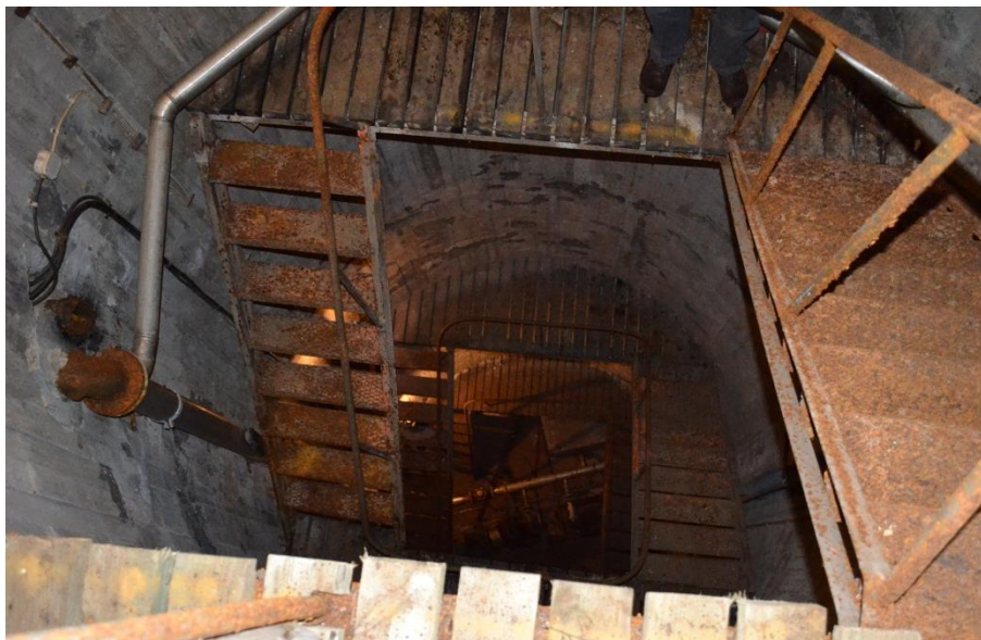
Kuva 12 Vanha kuilukaivo (Kosunen 9.1.2013.)
