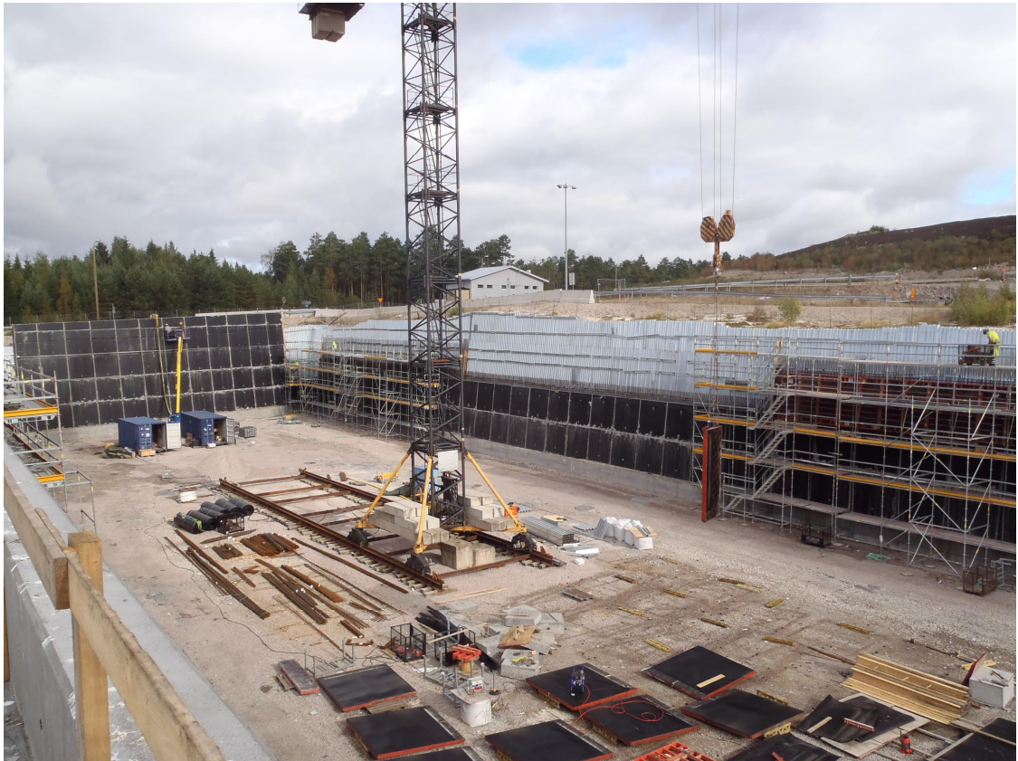
Kuva 14. Tuhkien loppusijoitussolun T1 rakennustyömaa vuodelta 2012 [12].
