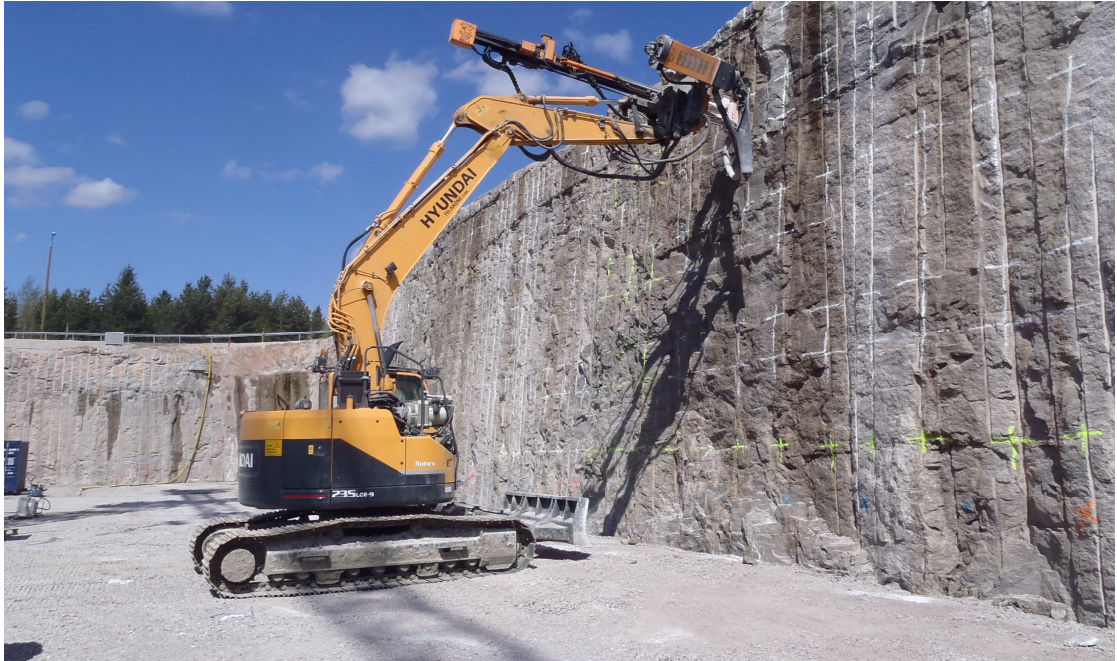
Kuva 11. Poraustyöt profiilipeltin tartuntoja varten T1-solun työmaalla 2012 [12].
