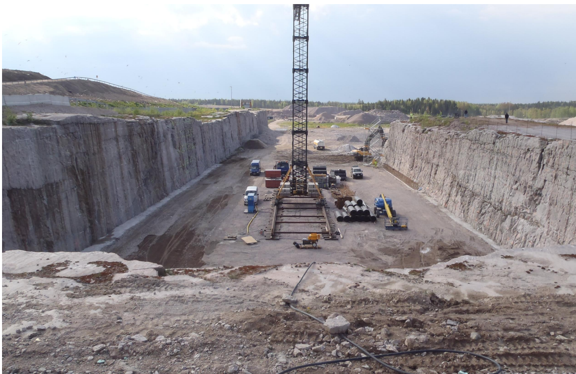
Kuva 9. Loppusijoitussolu T1 rakennustyömaa toukokuussa 2012 [11].
