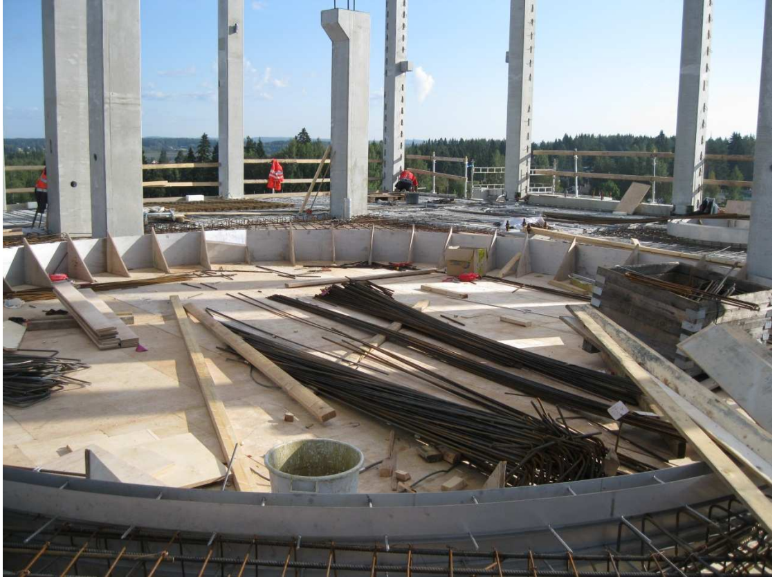
Kuva 5. Iso haalausaukko muottivaiheessa, muotin purkuvaiheessa työturvallisuus realisoituu, putoamissuojaus on tehtävä huolellisesti. Kuva Marko Savolainen 2012.
