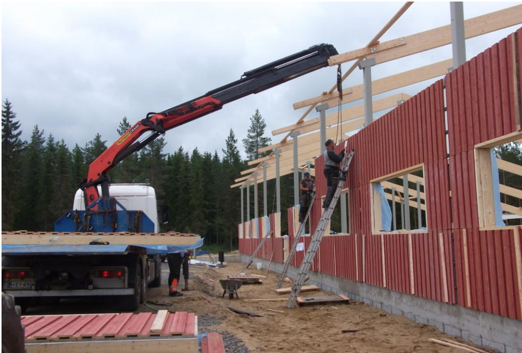
Kuvio 10. Navetan korkean osan seinäelementtien asennus (Tapio Husa)
