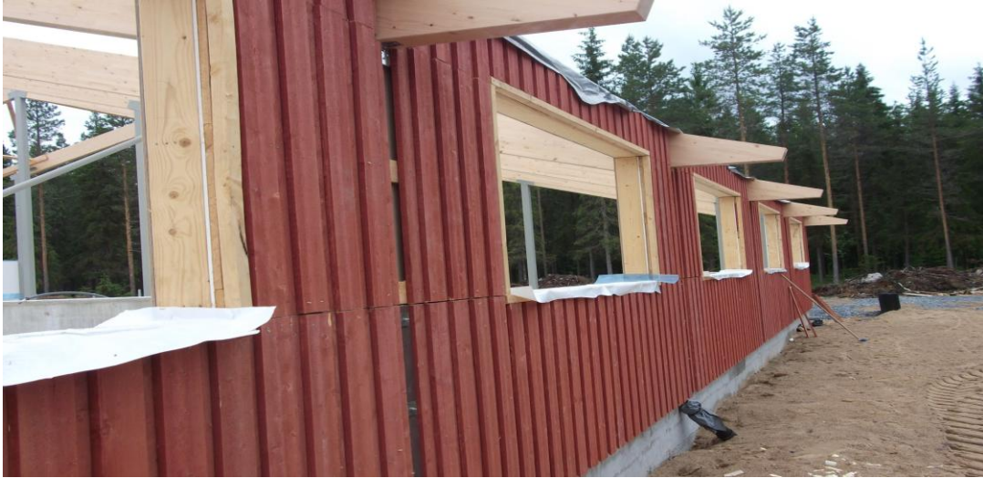
Kuvio 9. Navetan matalan osan seinäelementit asennettuna (Tapio Husa)
