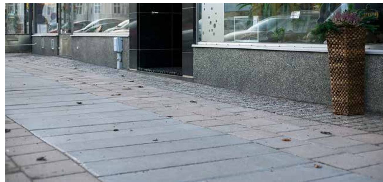
Betonilaatta, harmaa, sileä Betonilankkulaatta, harmaa, sileä Noppakivi, Taivassalon ruskea, yläpinta poltettu, sivut lohkottu Nupukivi, Taivassalon ruskea, yläpinta poltettu, sivut lohkottu Noppakivi, Kurun harmaa, yläpinta poltettu, sivut sahattu Noppakivi, Varpaisjärven musta, yläpinta poltettu, sivut sahattu Reunakivi, Taivassalon punainen, näkyvät pinnat piikattu Asfalttibetoni
