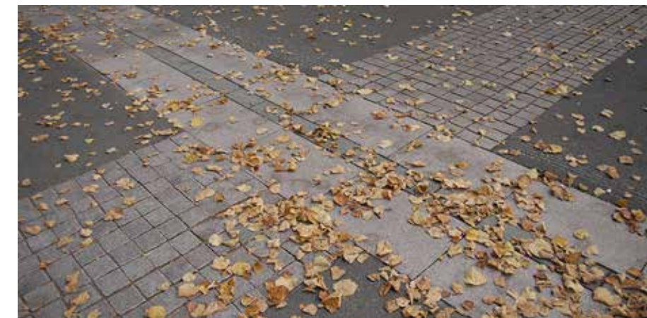
Kivilaatta, Liedon punainen, yläpinta poltettu, sivut sahattu. Noppakivi, Liedon punainen, yläpinta poltettu, sivut lohkottu. Nupukivi, Liedon punainen, yläpinta poltettu, sivut lohkottu. Asfalttibetoni.
