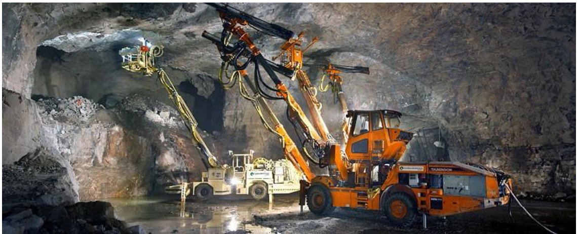
Kuva 5. Kalliotilan louhintatyöt käynnissä Stockmannin parkkihallissa [14].
