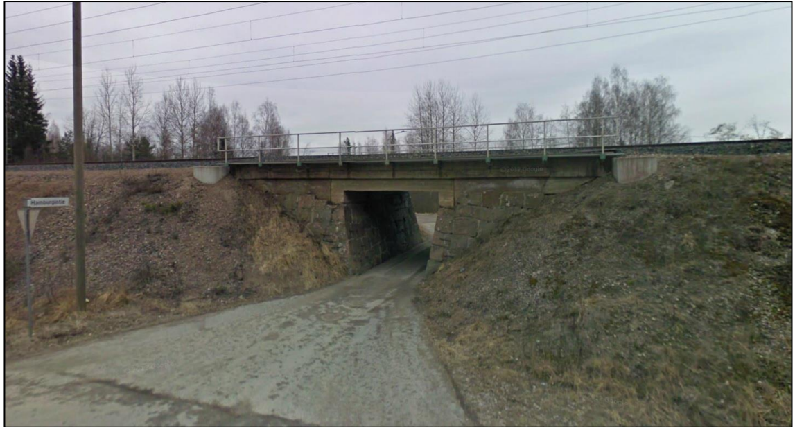
Kuva 11. Hamburgintielle johtava alikuilu. (Kuva Google maps.)
