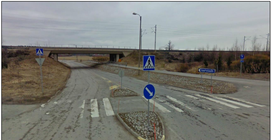
Kuva 10. Haapasaarentielle johtava alikulku. (Kuva Google maps.)
