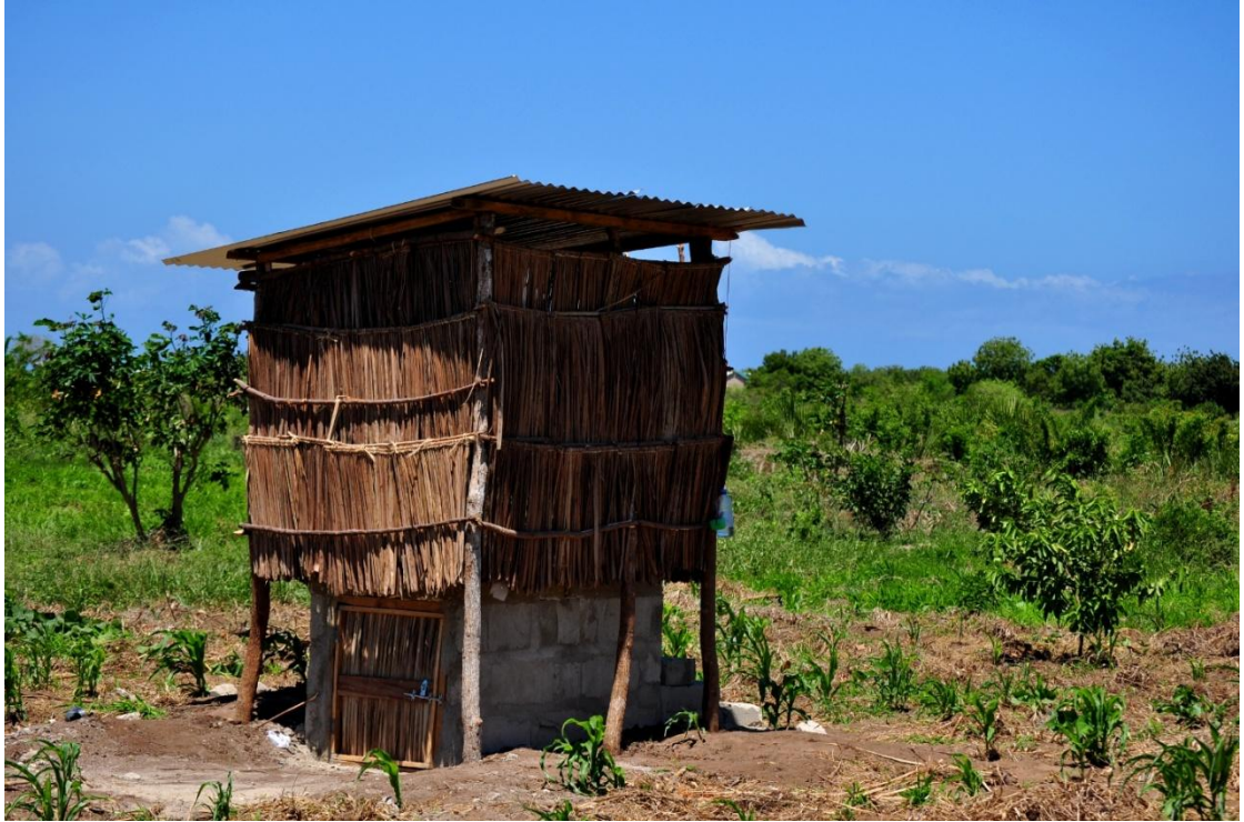
KUVA 18. Valmis kuivakäymälä. (Ojala 2012.)
