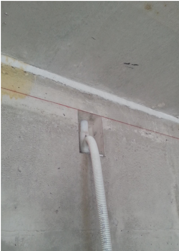
Kuva 12. Sopimusasiakirjojen mukaisesti tehty seinäelementin ja ontelolaatan välinen sauma [Vili Rinne]
