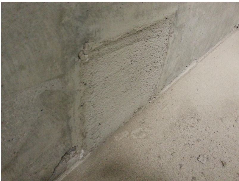
Kuva 14. Sopimusasiakirjojen mukaisesti tehty tartuntavarauksen täyttö [Vili Rinne]
