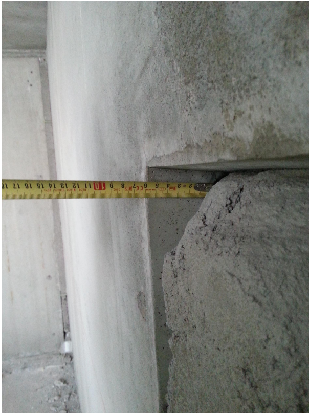
Kuva 3. Seinässä vajaaksi jäänyt juotosvalu on etuoikaistava ennen pinnan tasoittamista [Vili Rinne]
