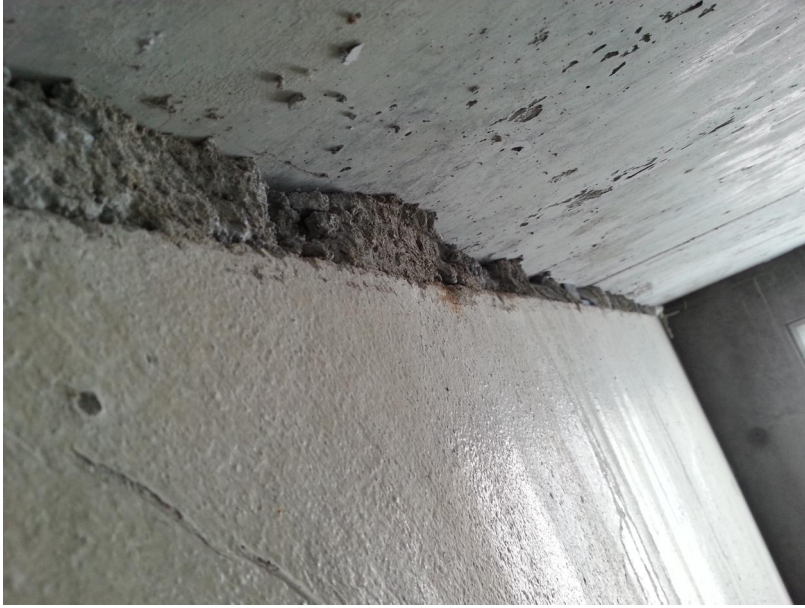
Kuva 11. Etuoikaisua vaativa seinäelementin ja ontelolaatan välinen sauma [Vili Rinne]
