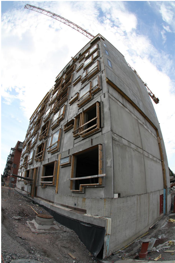
Kuva 4. Betonielementtirunko [Vili Rinne]
