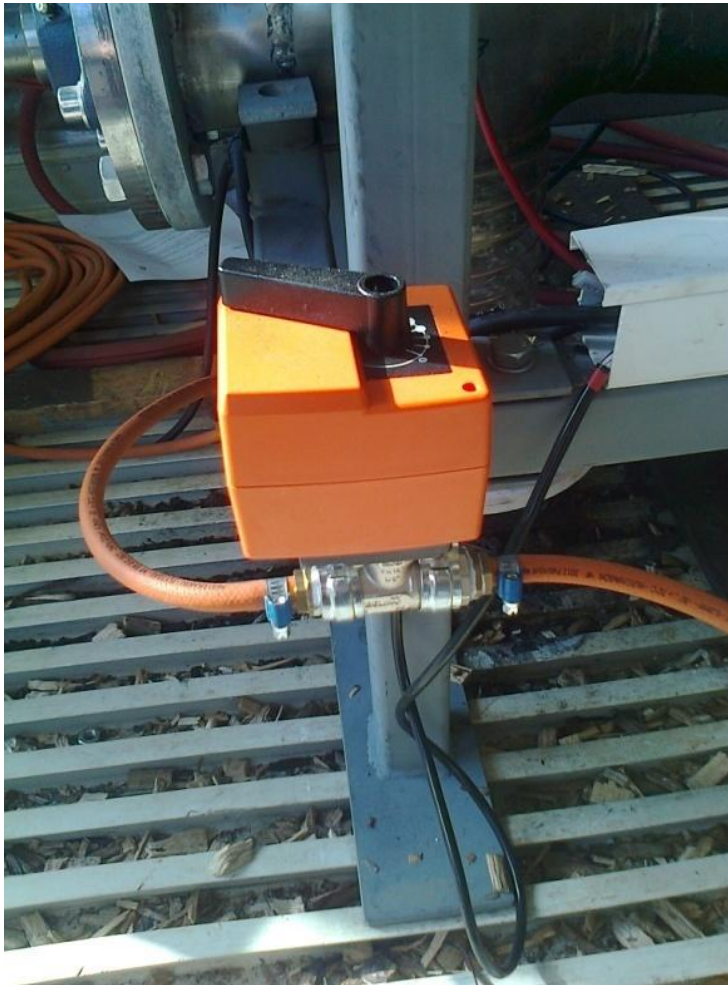
Kuva 2. Polttimen tehon säätöventtiili
