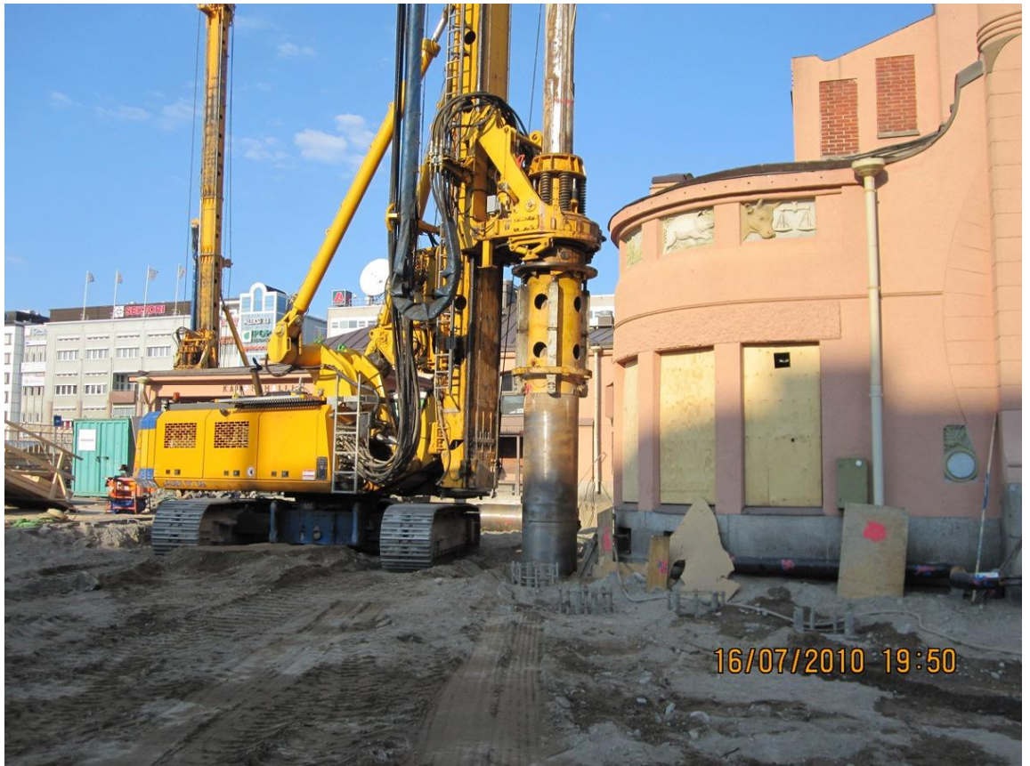
KUVA 2. Kaivinpaalujen tekoa Kauppahallin vieressä. Kuva Antti Leskinen 2010
