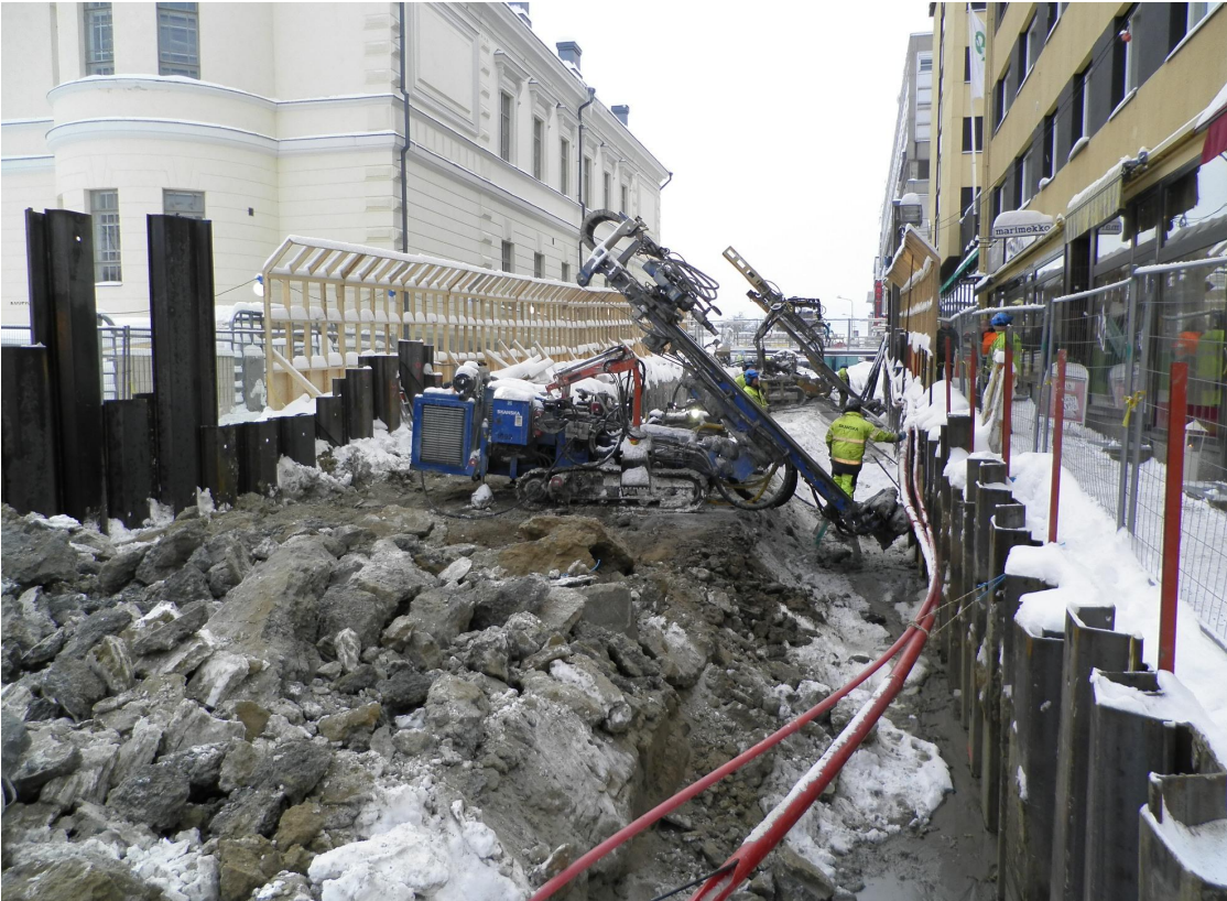
KUVA 4. Teräsponsittiseinää ja Ankkurireikien porausta Puijonkadulla. Kuva Antti Leskinen 2011
