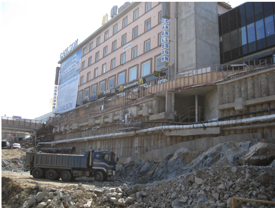
KUVA 1. Louhintaa Carlssonin edustalla. Kuva Antti Leskinen 2011
