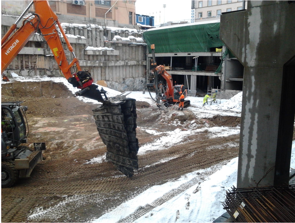
KUVA 13. Louhintaa entisen Kalahallin kohdalla. Kuva Tatu Kukkonen 2012
