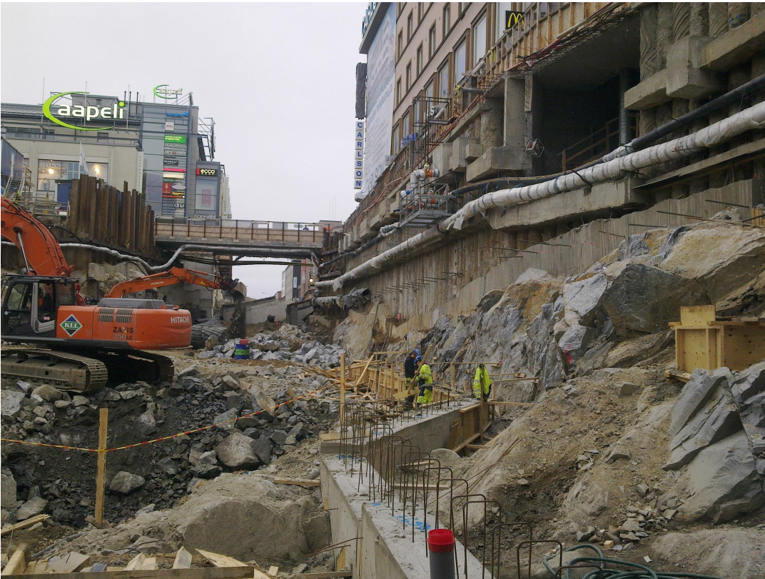
KUVA 14. Louheen kuormauska kaivinkoneella kallio syvennyksestä. Kuva Antti Leskinen 2011
