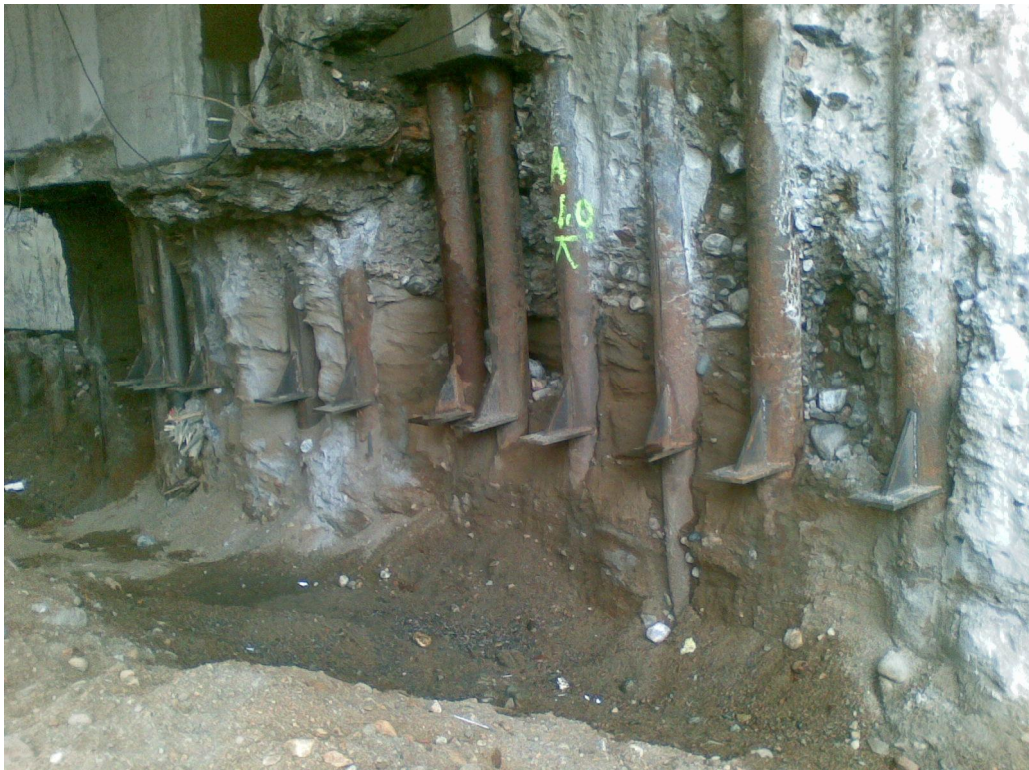
KUVA 6. Porapaaluja, joiden takana suihkupaaluja. Kuva Antti Leskinen 2011
