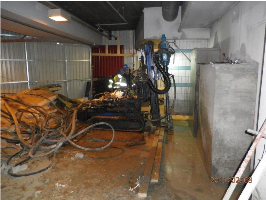
KUVA 7. Suihkuinjektointia kellarivaunulla vanhan torikannen alla, Sokoksen edustalla. Kuva Antti Leskinen 2011
