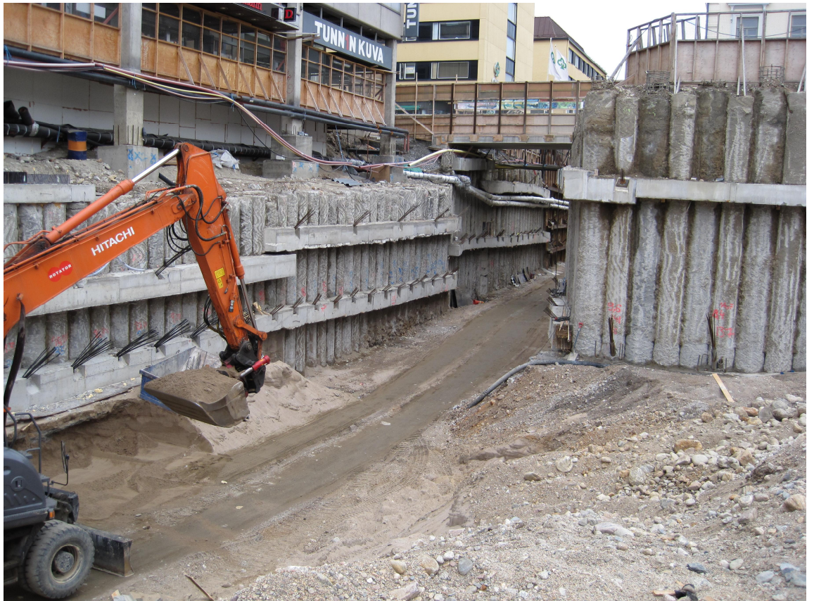
KUVA 3. Kaivinpaaluseinää ja ankkuripalkkeja Anttilan edustalla. Kuva Antti Leskinen 2011
