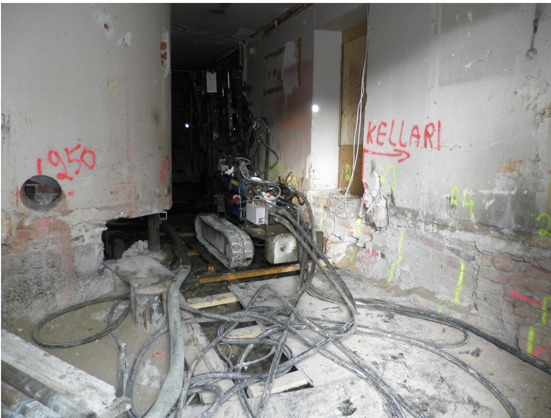
KUVA 8. Porapaalujen porausta kellarivaunulla Kalahallin sisällä. Kuva Antti Leskinen 2011
