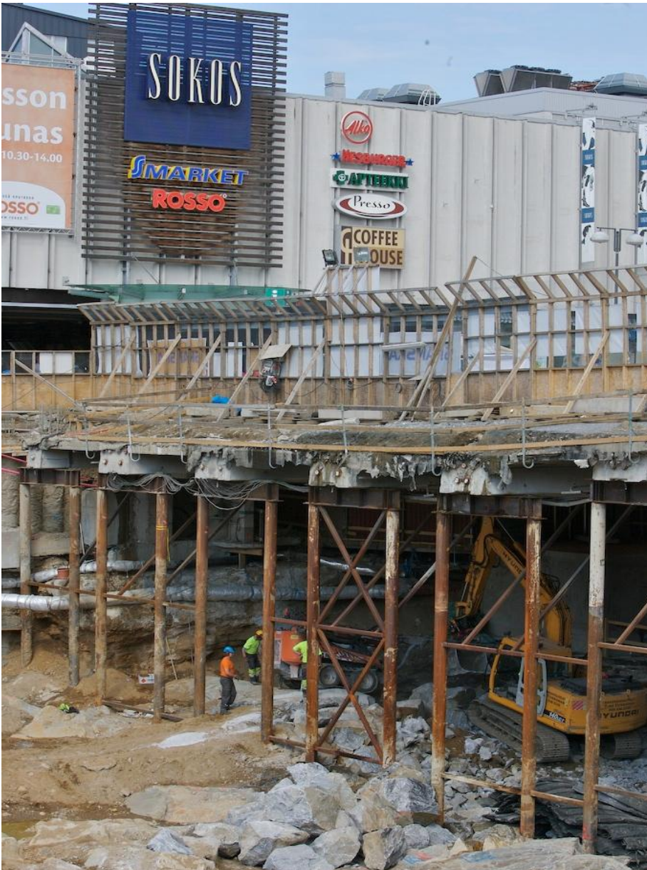
KUVA 12. Louhintaa vanhan torikannen alla. Kuva Antti Leskinen 2011
