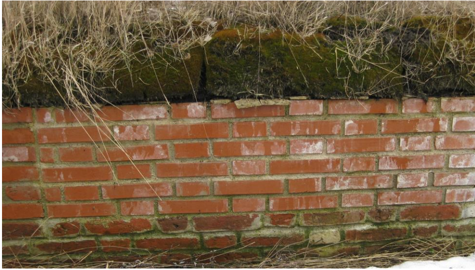
Kuva 25. KS50/50- laastilla tehty koemuuraus on säilynyt uuden veroisena lukuun ottamatta tiilien pinnalla olevaa valkoista kerrostumaa.
