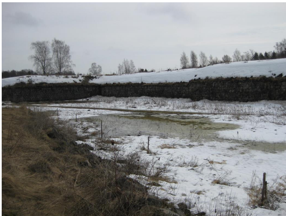
Kuva 13. Bastioni kolmessa otetussa kuvassa näkyy lammikoitumisongelman laajuus.
