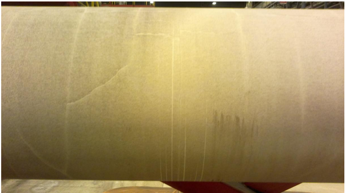
Kuva 12. Halkeamia kannatinrullan pinnassa
