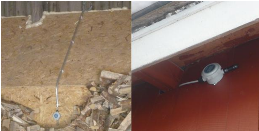
Kuva 9. Anturit paikoilleen asennettuna.
