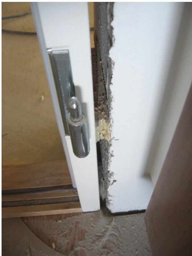
KUVA 15. Kiilojen päät katkaistaan karmin tasoon
