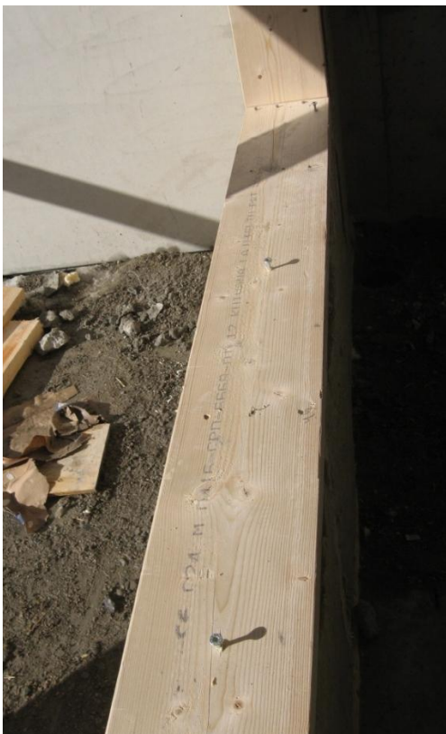
KUVA 7. Ruuvit, joiden avulla säädetään ikkunan karmi oikeaan korkoon
