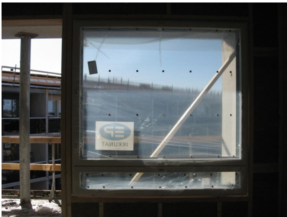
KUVA 10. Ikkunan suojamuovit jätetään paikoilleen
