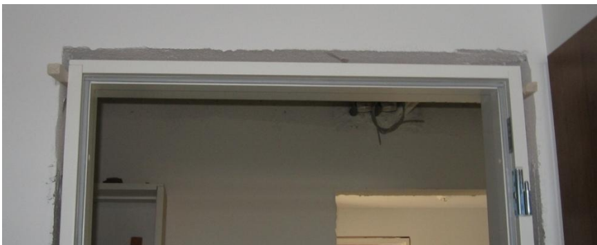
KUVA 13. Karmi kiillataan paikoilleen kiilojen avulla
