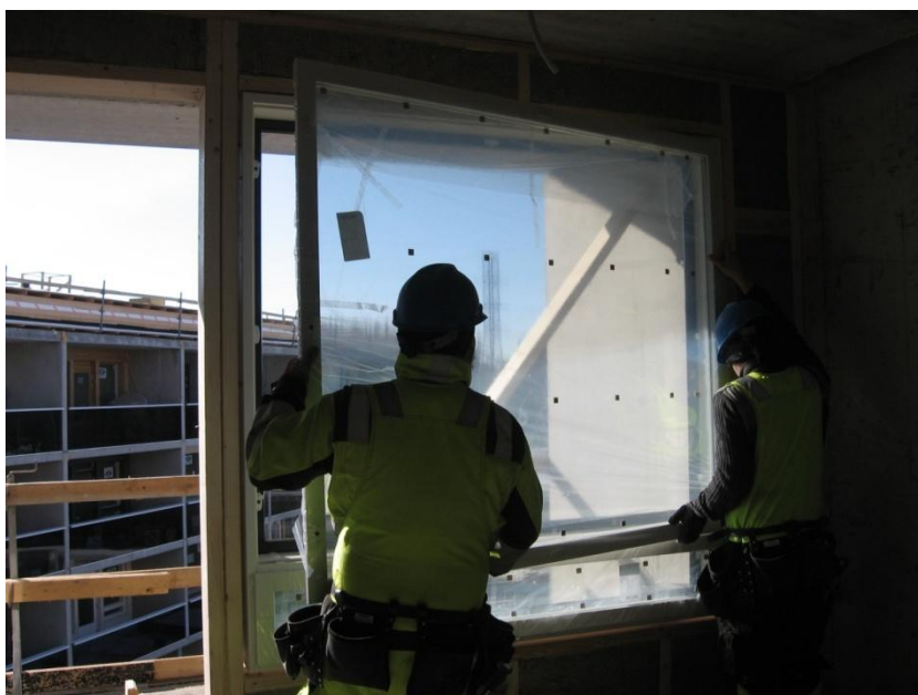
KUVA 9. Puitteet nostetaan paikoilleen
