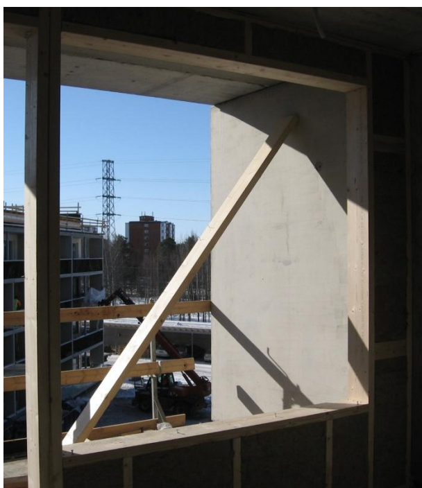
KUVA 6. Seinän kiinnityspintojen tulee olla puhtaat, eivätkä ne saa sisältää mitään asennusta haittaavia tekijöitä
