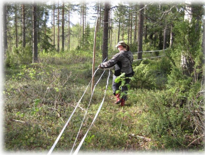
Kuva 31. Kolminkertaisen sähkölangan rullausta.
