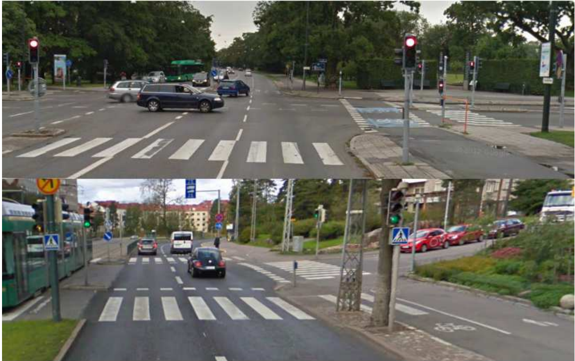
Kuva 34. Malmön suojatiekriteerien mukaan suojateitä ei merkitä pyöriteille, jolloin jalankulkijan on väistettävä pyöräilijöitä ylittäessään pyörätien. Käytäntö ei ole kuitenkaan kansallinen ja esimerkiksi Tukholmassa suojateitä on käytetty myös pyöriteillä. Suomessa käytäntöä ei ole ohjeistettu. Yläkuva on Malmöstä ja alakuva Helsingistä. [56]
