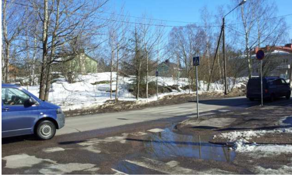
Kuva 36. Suojateitä ei tulisi sijoittaa kävelyreiteille, joilla ei ole talvikunnossapitoa. [54]
