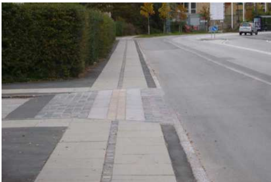
Kuva 32. Sivukadun yli jatkettu jalkakäytävä. [49, s. 26]
